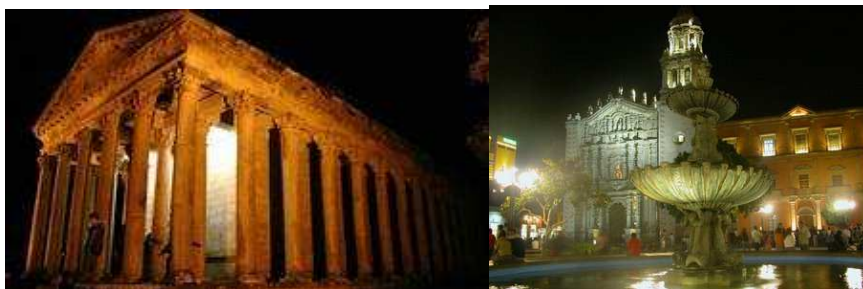
IMAGEN 23 y 24. Tipos De Iluminación Monumental En Edificios Históricos
