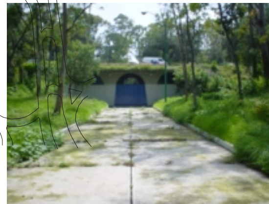
La apertura el paso a desnivel permite el paso mencionado
