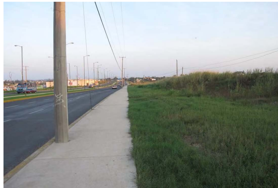
VISTA PANORAMICA LADO ESTE
