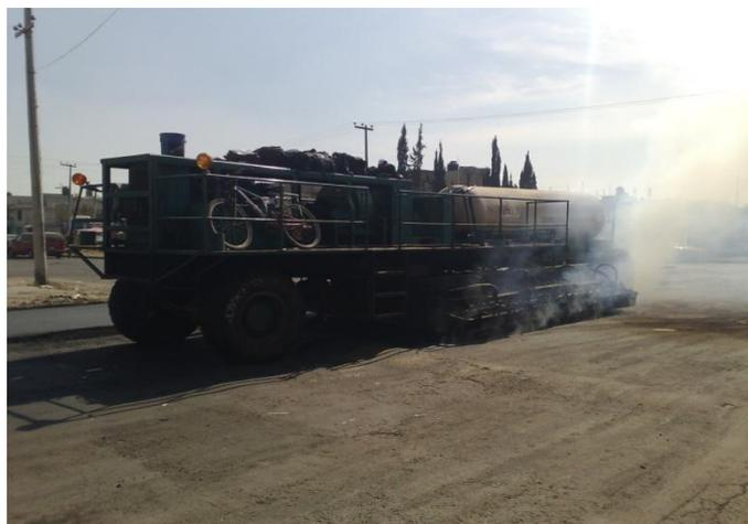
Calentado del asfalto existente con el Precanetador.
