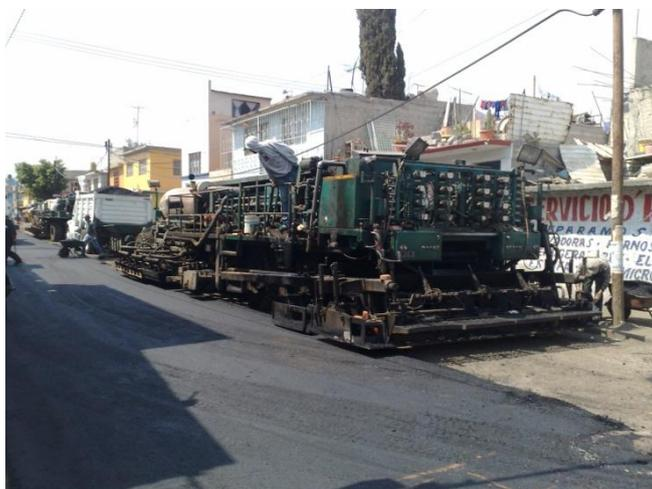
Posicionamiento de la recicladora para dar inicio a los trabajos de reciclado
