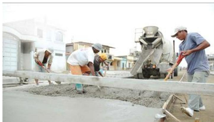
**Fig. 1.1.1** Fotografías de la elaboración y el fraguado de una capa de rodadura de un pavimento rígido.
