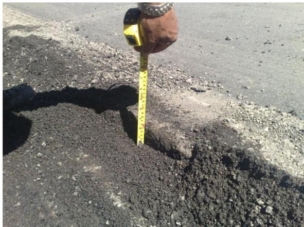
Verificación del espesor perfilado.
