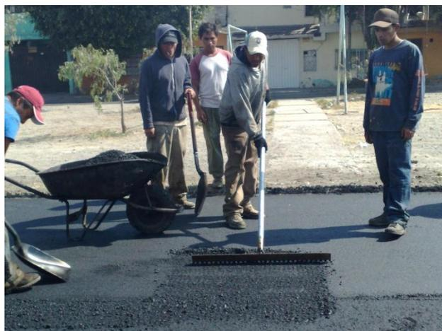
Desvanecido de la junta de dos secciones de carpeta asfáltica
