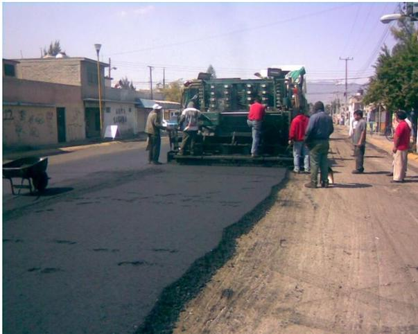
Tendido y planchado de asfalto del proceso de reciclado de asfalto a un paso
