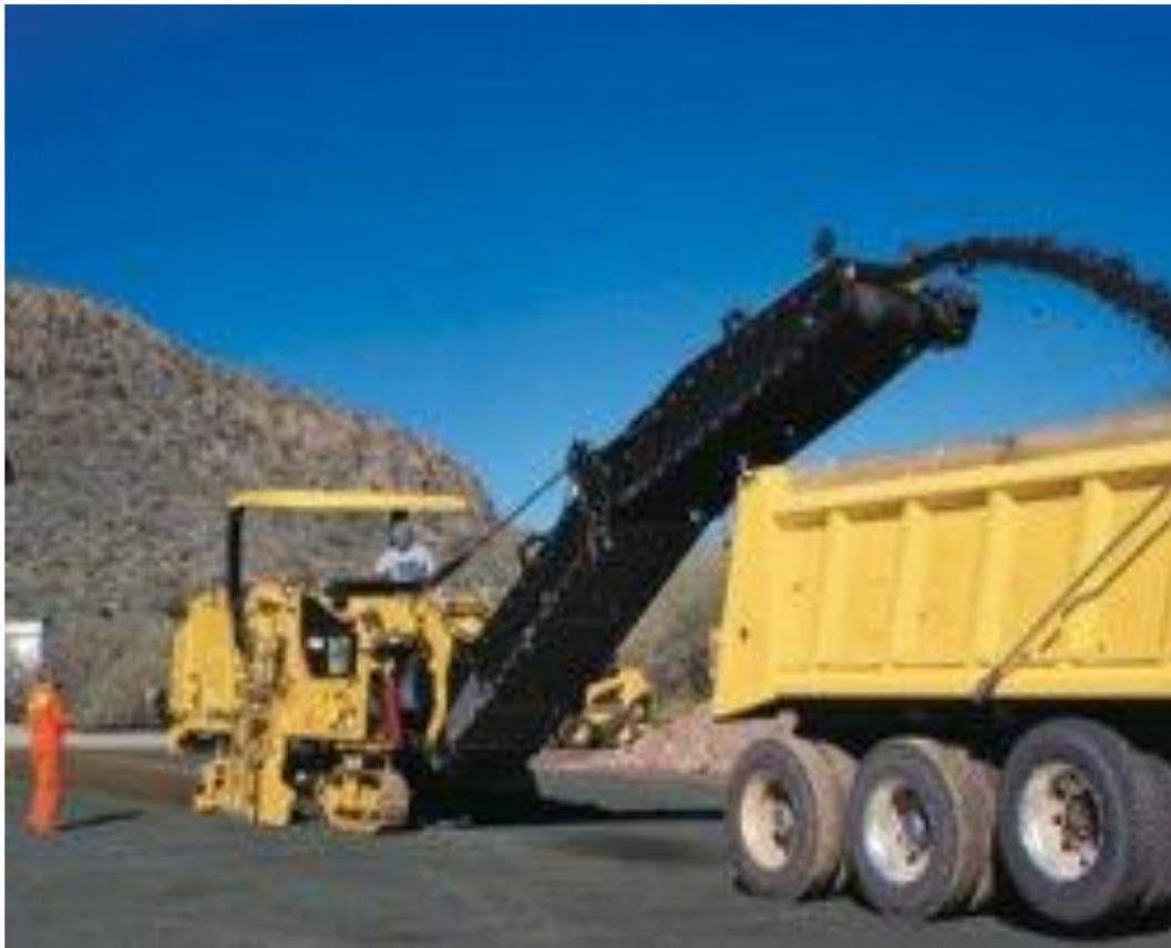
**7.3.5.** Imagen de una perfiladora de asfalto.
