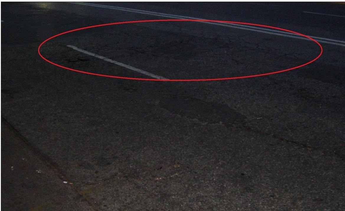
Fotografía 8. Oxidación y agrietamiento tipo cocodrilo.
