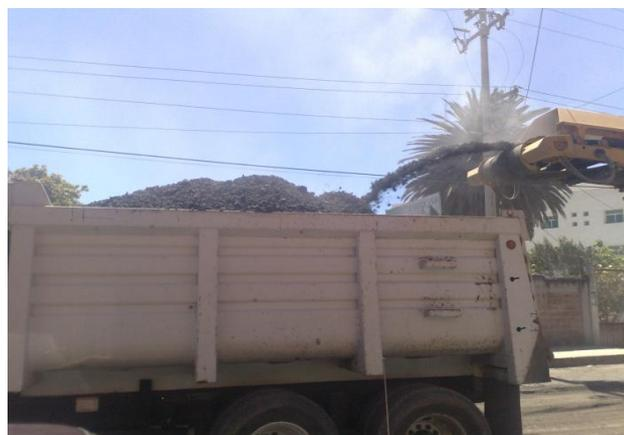
Molienda de asfalto cargado con ayuda de la banda transportadora .
