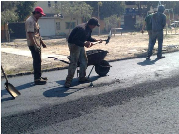
Retiro y acarreo de material sobrante (mezcla asfáltica)
