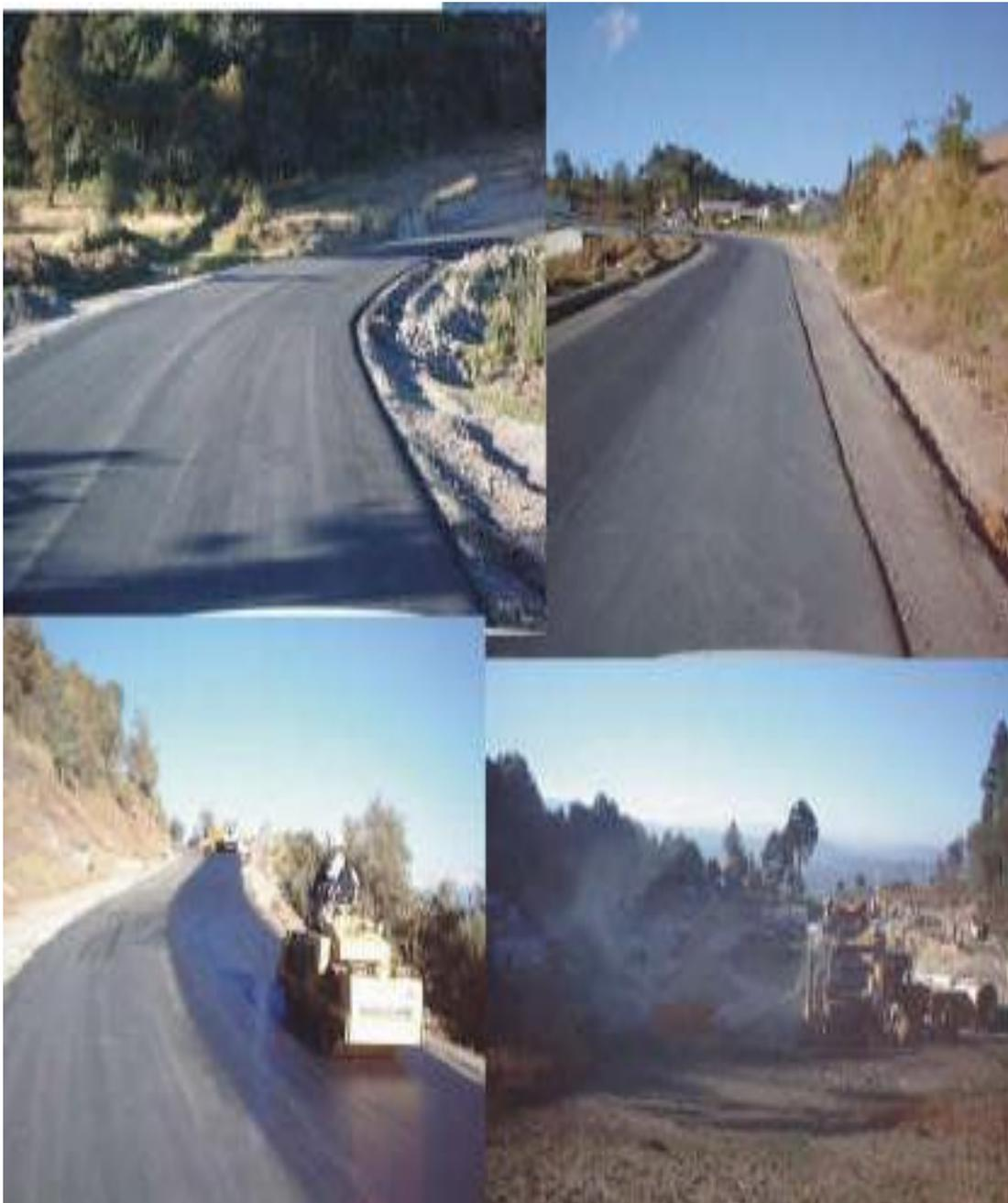
**Fig. 1.1.2** Fotografías del compactado de la sub-base y de la capa de rodamiento de un pavimento flexible.
