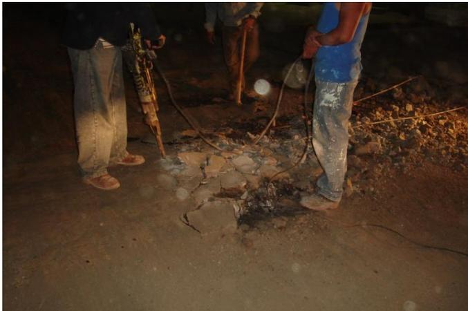
Retiro de topes de concreto con rotomartillo neumático
