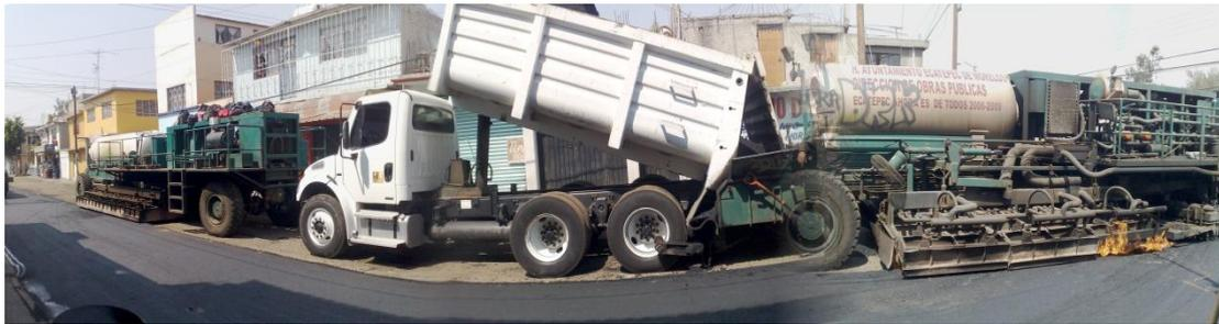
Tren de reciclado de asfalto a un solo paso
