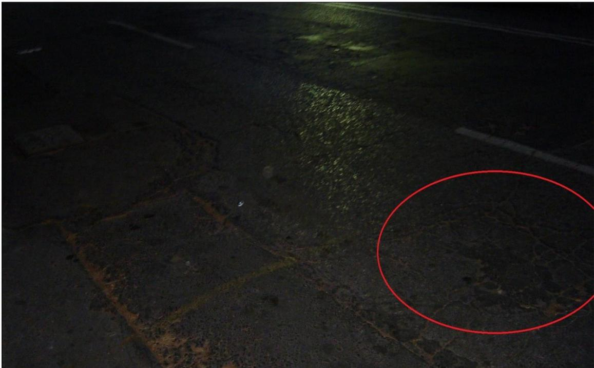
Fotografía 10. Oxidación, agrietamiento tipo cocodrilo y disgregación.
