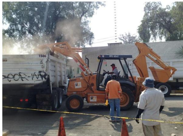
Carga con retroexcavadora del fresado que no fue cargado con la banda transportadora.
