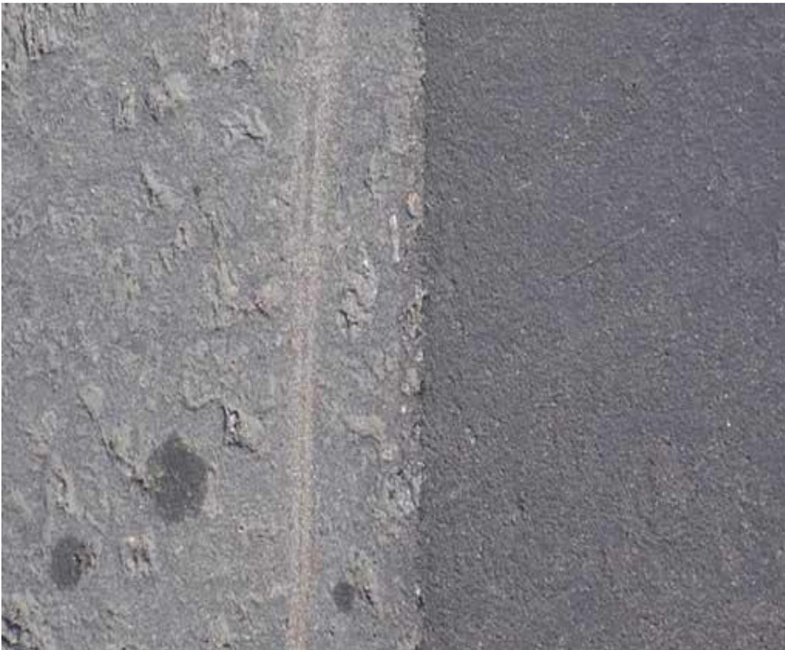
**5.1.7.** Fotografía de una carpeta asfáltica con una sección con problemas de oxidación y otra sección reparada a base de un sello asfáltico.
