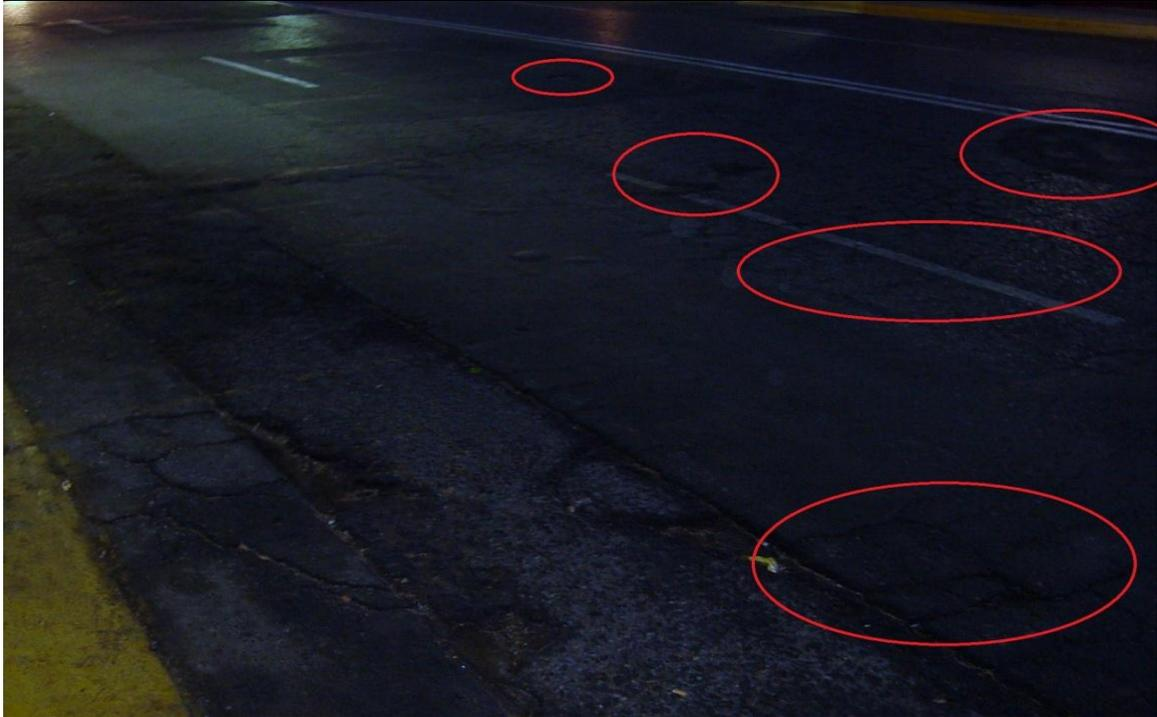
Fotografía 9. Disgregación y agrietamiento tipo cocodrilo.
