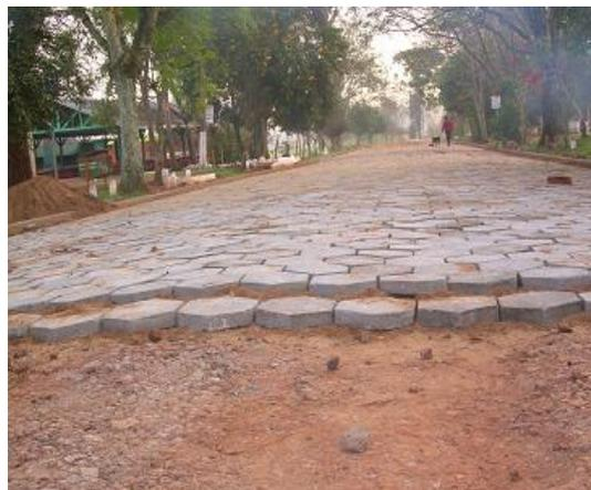
Fig. 1.1.4 Fotografías de la velación y colocación de un pavimento articulado.
