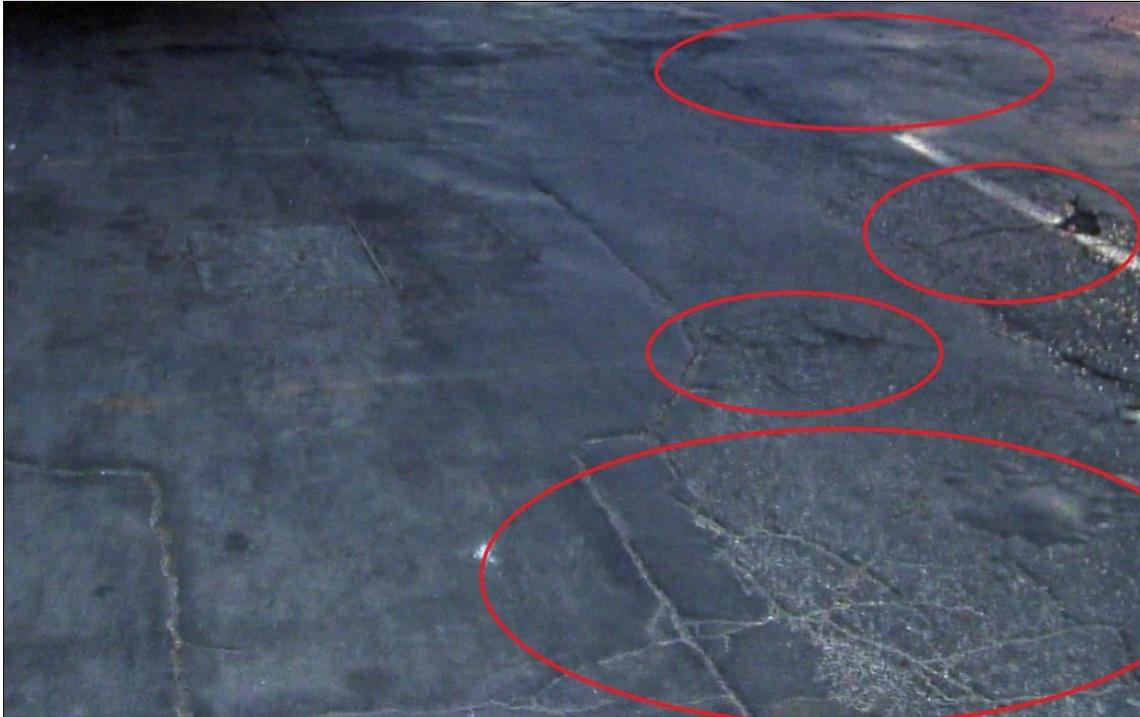
Fotografía 3. Agrietamiento y disgregación
