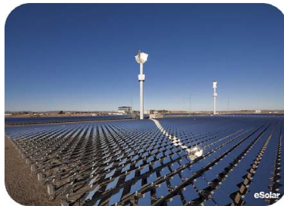
Fig. 5: Concentrador solar de campo de helióstatos [33]
