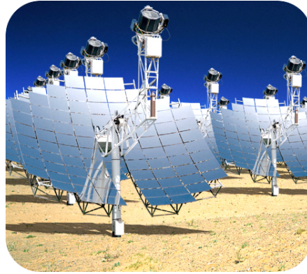
Fig. 6: Concentrador solar de plato parabólico [33]
