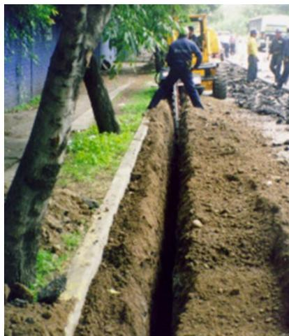
5.- Si el tramo presenta tomas domiciliarias, se debe verificar a sobre el trazo a que altura se deberá ampliar la zanja esto para que se permita el trabajo de termofusionado de silletas y la colocación del ramal. Esta ampliación también se puede considerar como cala de verificación.
