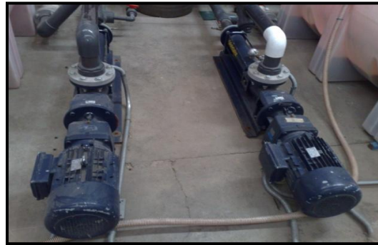
Fig.2.5 Bombas de cavidades progresivas.
