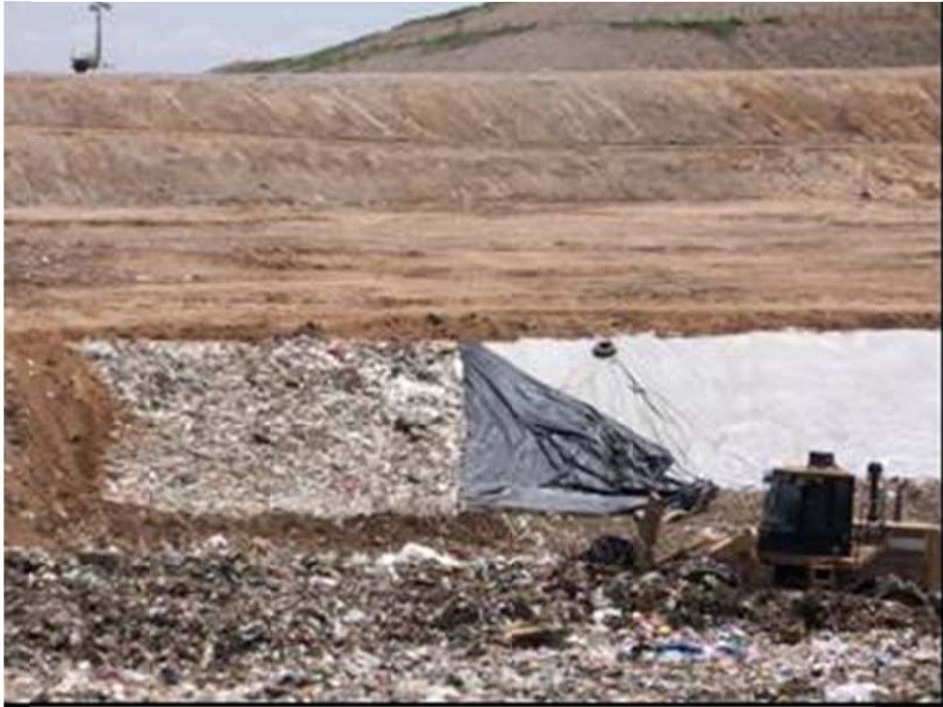
Imagen 9. Levantamiento de lonas. Relleno Sanitario de Naucalpan de Juárez, Estado de México.
