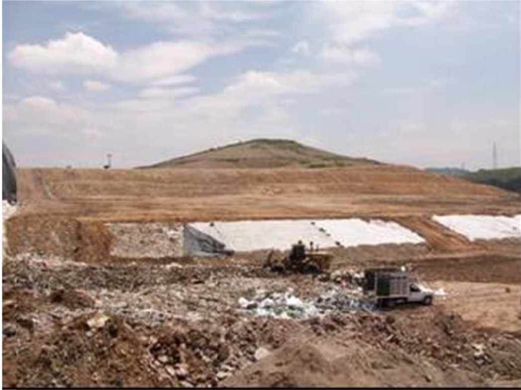
Imagen 8. Levantamiento de lonas. Relleno Sanitario de Naucalpan de Juárez, Estado de México.
