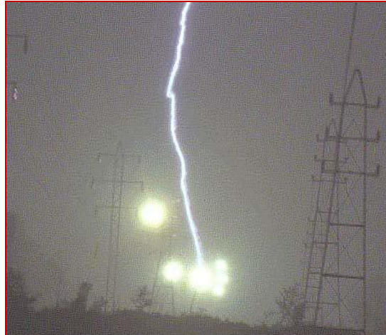
Figura 24. Imagen de la Caída de un Rayo Cerca de Líneas de Transmisión de Energía Eléctrica Provocando Transitorios Tipo impulso.
