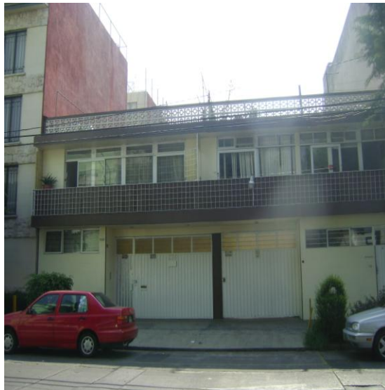
Fachada principal de la casa donde se realizo la exploración, la cual colinda al poniente con la calle de Indiana.
