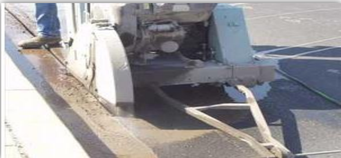
Figura 4.3.2.2 Zanjado para fibra óptica.
