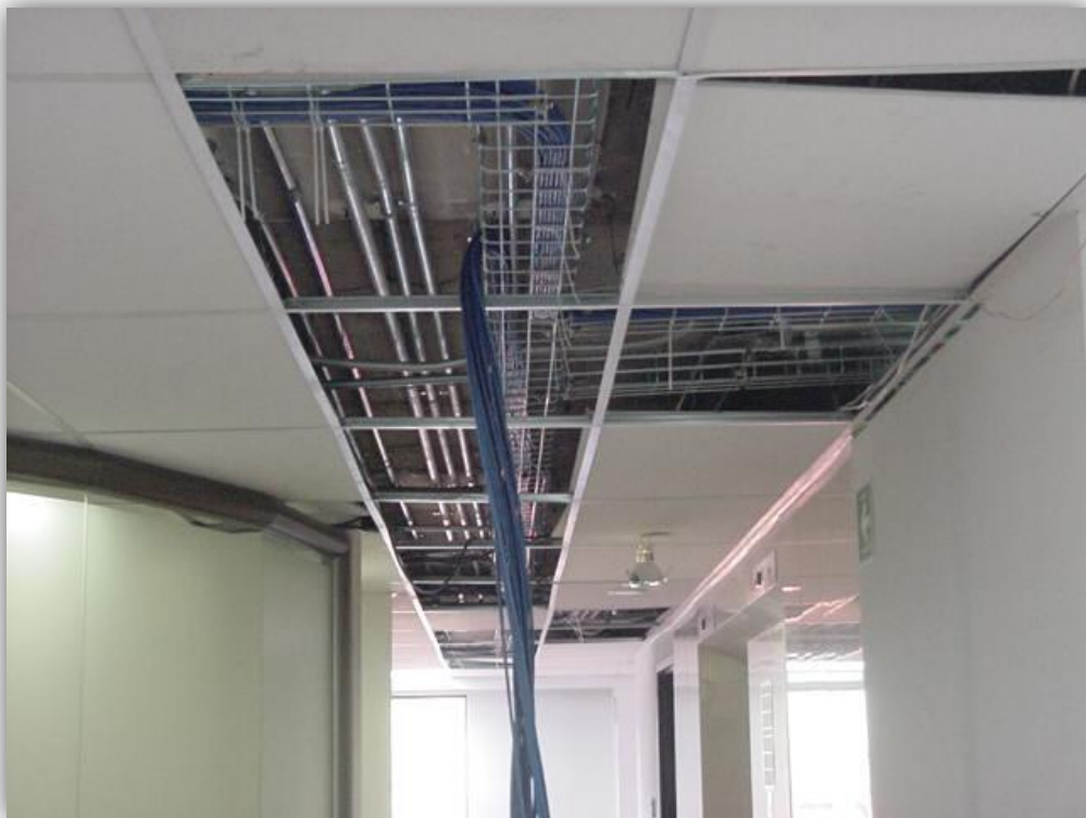
Figura 3.3.3 Ejemplo de instalación de cables con curvatura.
