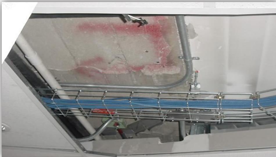
Figura 3.3.5 Ejemplo de separación de conductos eléctricos.
