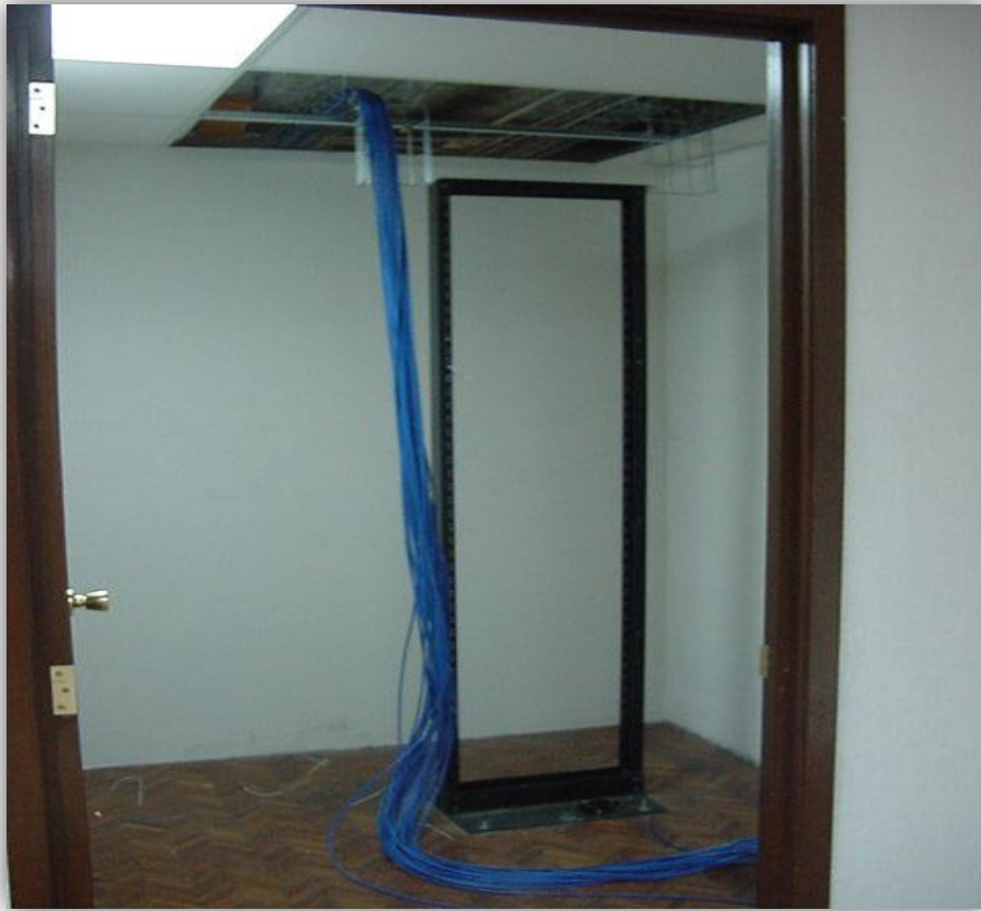
Figura 3.3.4 Ejemplo de amarrado de cables.
