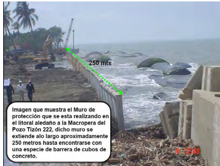
Figura B.24: Avance de la construcción del muro de protección en la zona de erosión
