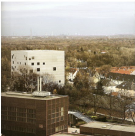
Vistas del exterior del edificio
