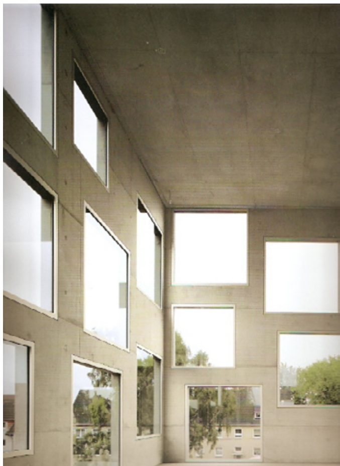
Vistas del interior del edificio
