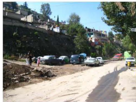
Fig. 35. Condición actual de avenidas circundantes al proyecto.
