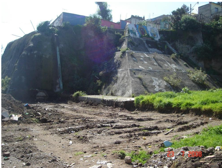
Fig. 28. Taludes de concreto realizados en los años 80's contención de la barranca
