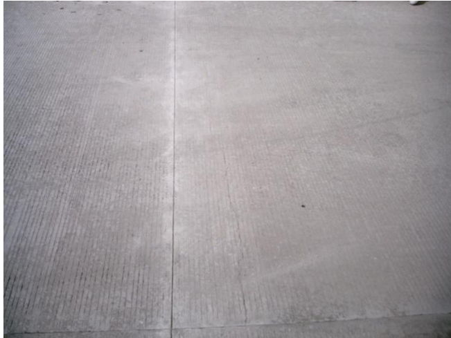
Figura 1.2. Junta colocada de manera transversal.
