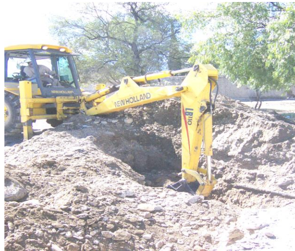
Figura 3.7 Excavación en derecho de vía.
