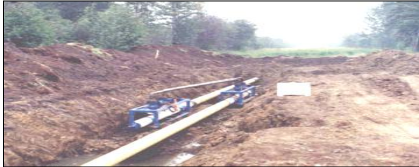
Figura 3.8 Poliducto enterrado
