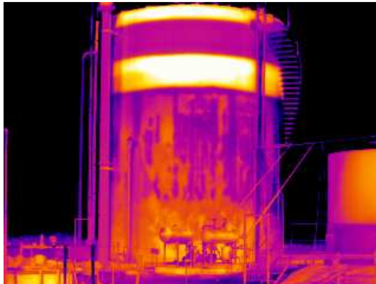
FIGURA 12. IMAGEN TÉRMICA DEL TANQUE “GUN BARREL”
