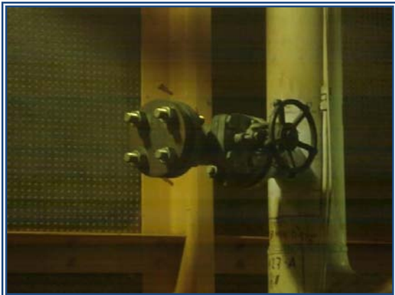
Instalación de Válvula de paso completo
