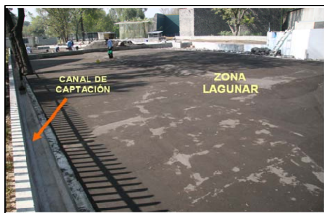
Fig. B.3.6 Canal de captación
