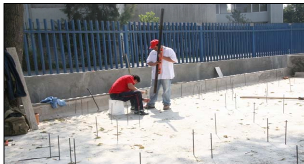
Fig. B.2.4 Topo- batimetría, nivelación de varillas.
