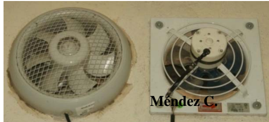
Foto 12.- Extractor (Izquierda), Ventilador (Derecha).
