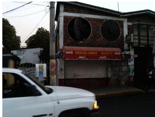
Se observan sistemas constructivos tradicionales, tabique y concreto.
