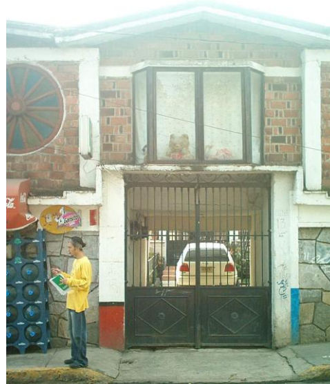
Vivienda en Calle Mina
