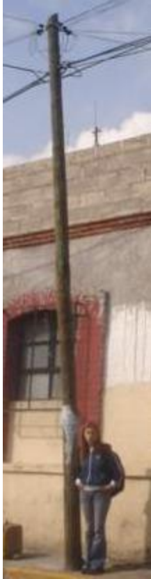
Postes de madera ubicado en la esquina de las calles Aldama y Porfirio Díaz.
