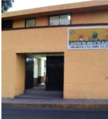
Aplanado de cemento-arena, en la mayoría de las construcciones.
