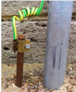
fig.2.18. Conexión a tierra
