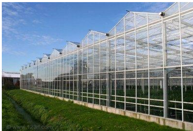
Fig.9.-Estructura de un invernadero holandés de tipo tejado encristalado sobre barras.
