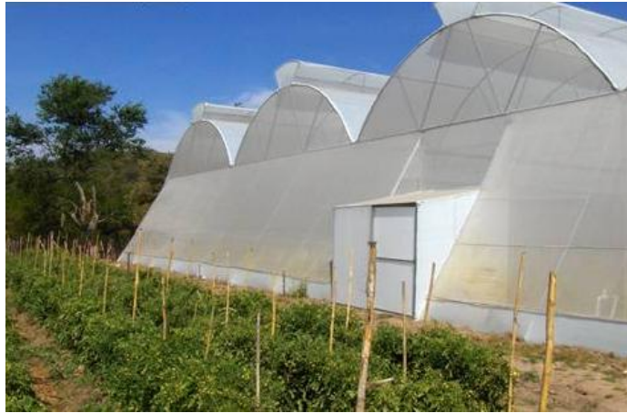
Fig.52.- Invernadero que permite mayor captación de energía por estructura tipo túnel.
