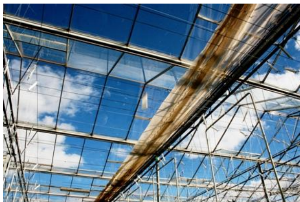
Fig.8.-Estructura de un invernadero holandés.
