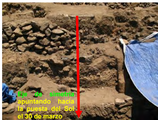
Figura 18. Diversos restos de pórticos de la estructura principal de El Rosario se dirigen a la mencionada intersección y depresión del horizonte poniente. Fotografía de Francisco Granados, abril de 2009.
