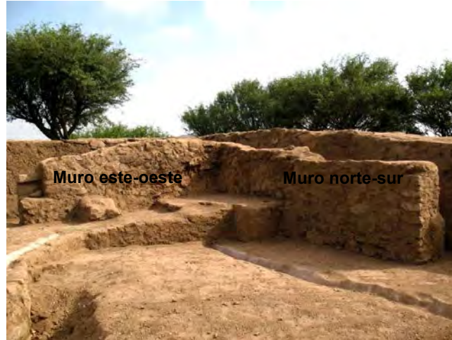
Figura 5. Fragmentos del cuarto superior del basamento principal de El Rosario, correspondientes a la Etapa IV. Como podrá notarse, de esta última fase de construcción, sólo permanecen los muros este-oeste y norte-sur, se alcanza ver una especie de banqueta o piso adosado a la esquina conformada por dichos muros. Fotografía de Francisco Granados, 8 de octubre de 2009.
