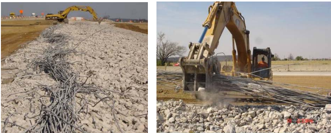
Figura 2.14 Remoción del acero de refuerzo en un pavimento de concreto (RMI, Inc.).
