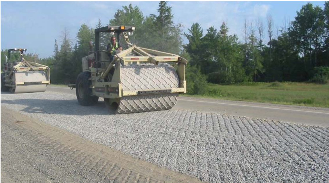
Figura 2.30 Compactadora con rodillo vibratorio con Z-grid (plantilla en Z), seguido de una compactadora con rodillo vibratorio liso (Antigo Construction Inc., 2005).
