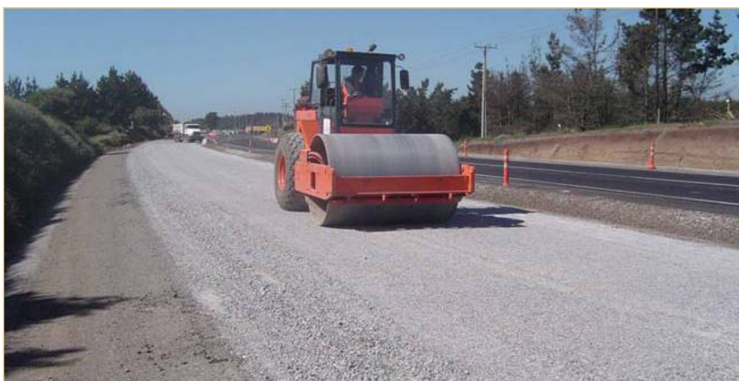
Figura 2.16 Compactación con rodillo liso vibratorio del material triturado (RMI, Inc.).
