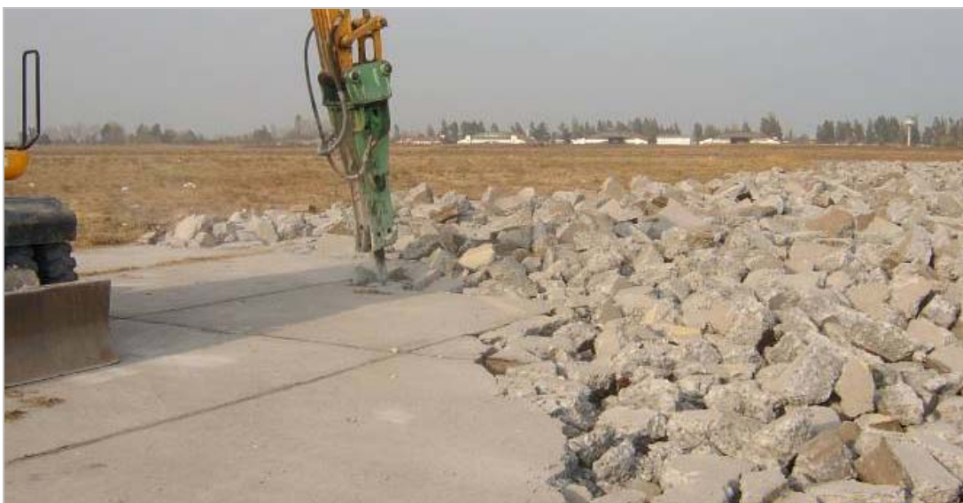
Figura 2.3 Técnica tradicional de rompimiento de una losa de concreto en un pavimento, utilizando retroexcavadora con martillo hidráulico (ACPA).
