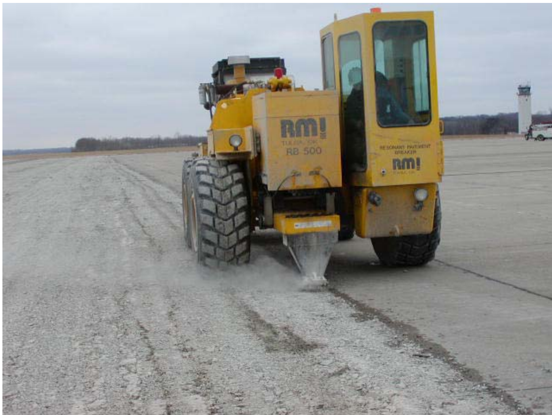
Figura 2.20 Máquina resonante rompedora de pavimento (RMI, Inc.).
