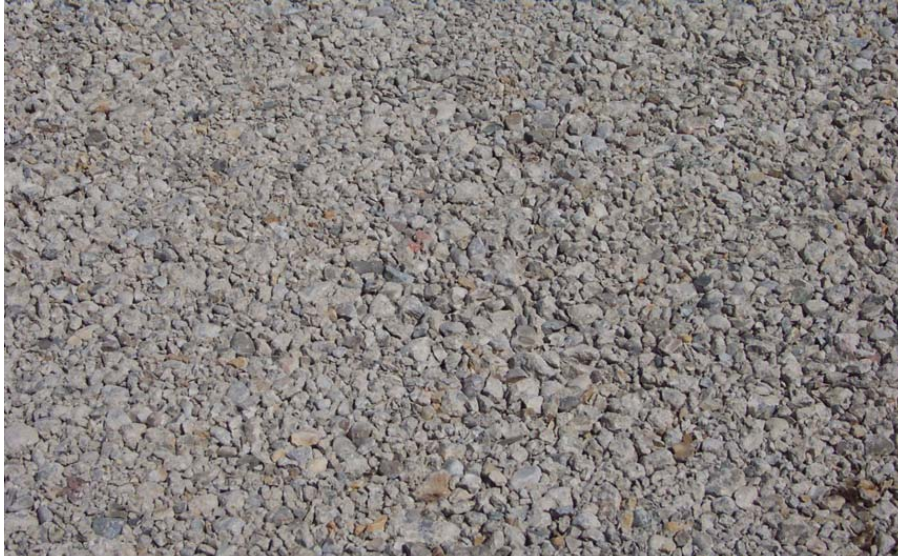
Figura 2.17 Superficie final después del proceso de rubblizing y de compactación de un pavimento de concreto triturado (Antigo Construction Inc.).
