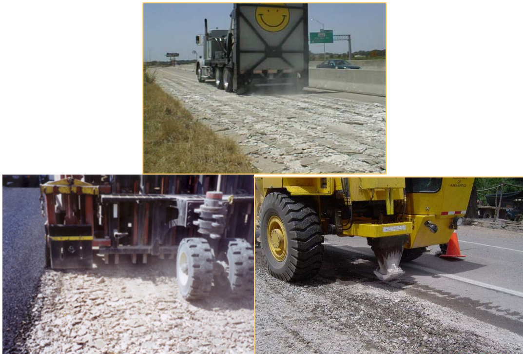
Figura 2.12 Proceso de rubblizing de pavimentos de concreto con diversos equipos.
