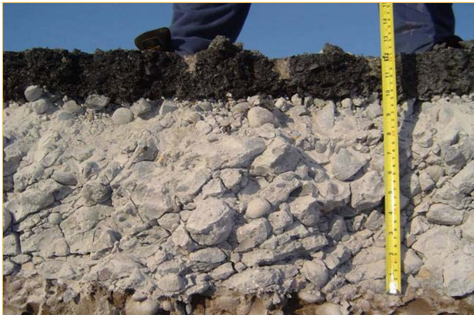
Figura 2.19 Espesor final de un pavimento de concreto reciclado después del proceso de rubblizing y la colocación de una carpeta asfáltica (RMI, Inc.).
