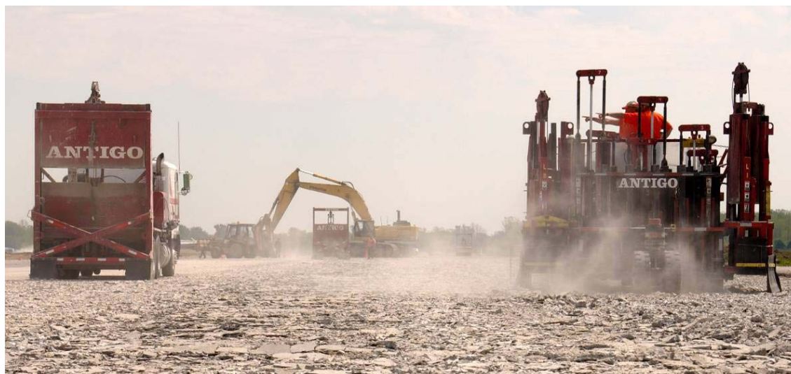
Figura 2.28 Proceso de rubblizing en una aeropista de pavimento de concreto con equipo tipo guillotina y MHB trabajando simultáneamente (Antigo Construction Inc., 2009).
