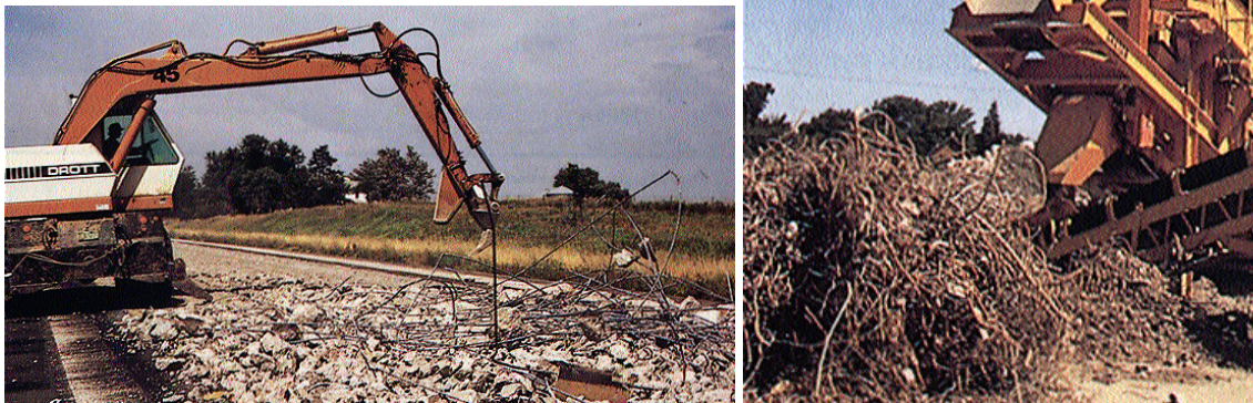
Figura 2.5 a) Retroexcavadora montada sobre orugas con cuerno de rinoceronte (rhino horn) para la remoción del acero de refuerzo, b) Banda electromagnética para la remoción del acero existente durante el proceso de trituración (ACPA, 1993).
