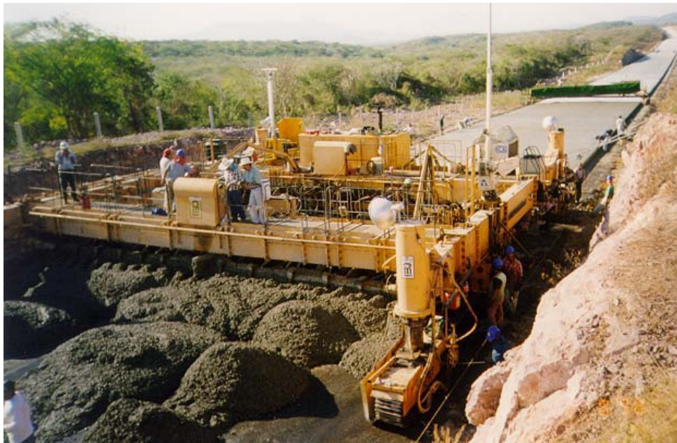
Figura 3.1. Colocación de concreto hidráulico con pavimentadora de cimbra deslizante (CEMEX, 2000).
