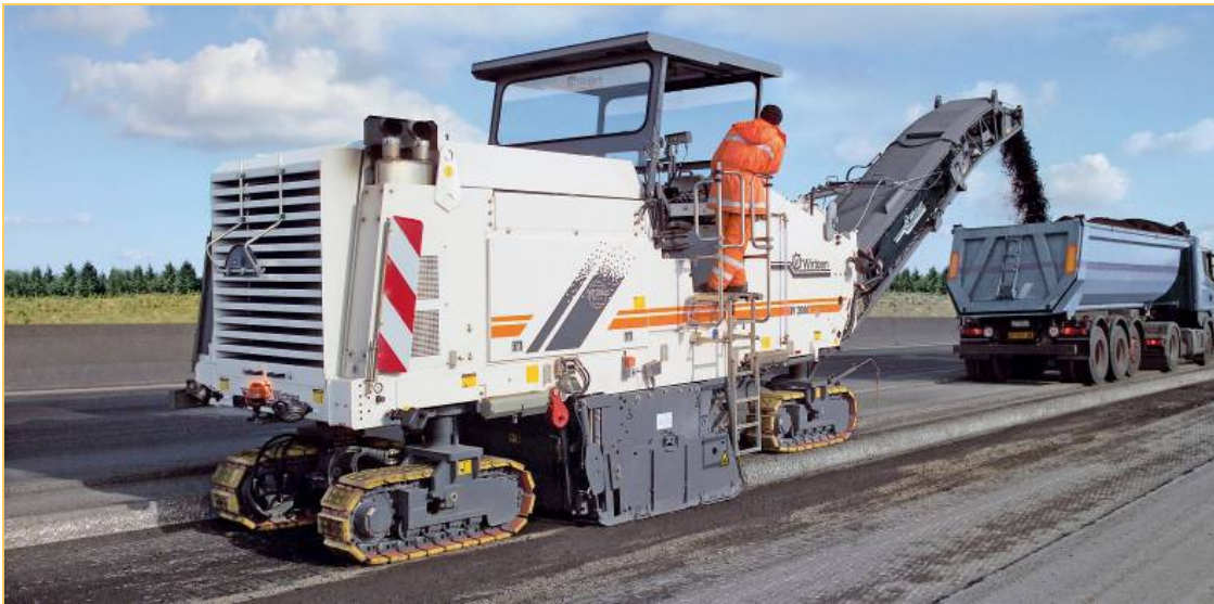
Figura 2.8 Proceso de fresado de una sobrecarpeta asfáltica (Antigo Construction Inc.).
