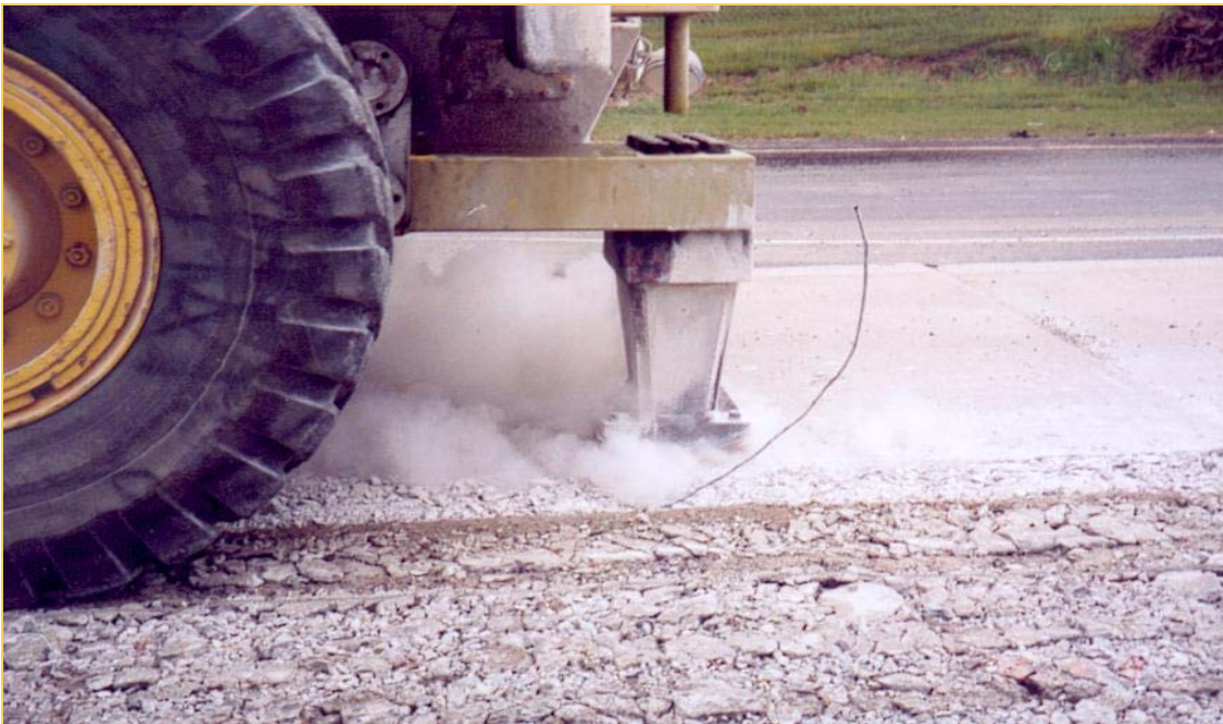
Figura 2.22 Viga resonante de un equipo rompedor resonante en operación (RMI, Inc.).
