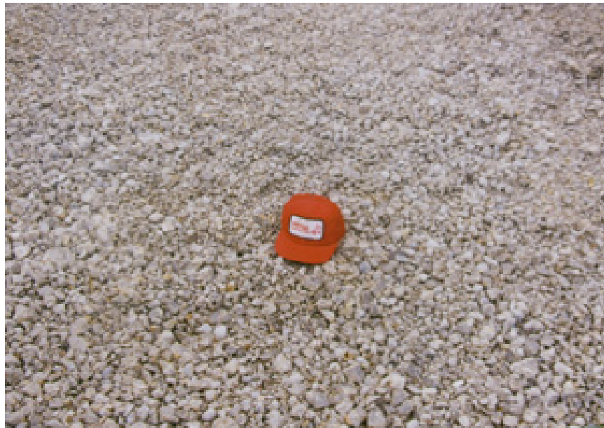
Figura 2.31 Superficie final después del proceso de rubblizing y compactación de un pavimento de concreto (Antigo Construction Inc., 2003).
