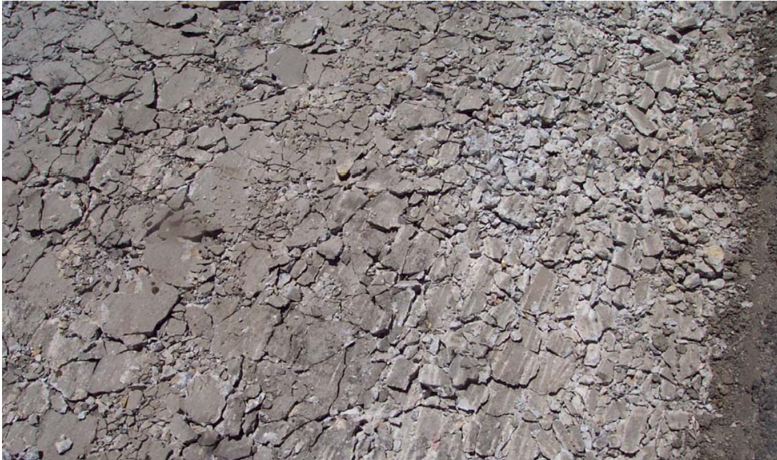
Figura 2.29 Superficie de un pavimento de concreto después del rompimiento con equipo MHB, donde se aprecian partículas de forma delgada (Antigo Construction Inc.).
