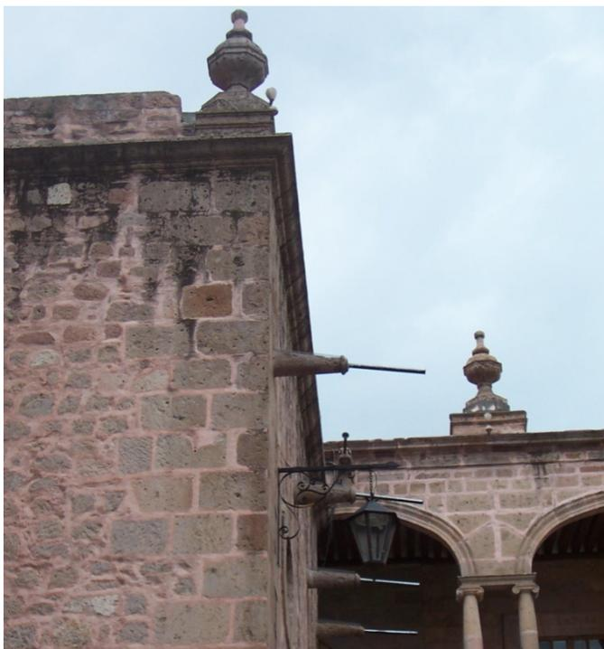
**GÁRGOLA:** f. Desagüe de los tejados para que el agua no caiga por el muro. **Gran Diccionario Enciclopédico ilustrado 1999. Grijalbo.**
