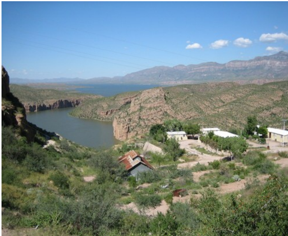
Figura 13: Presa La angostura sobre el río Bavispe en Sonora para uso agrícola y generación de energía eléctrica
