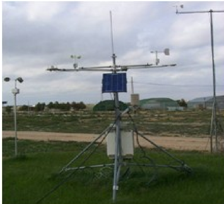
Figura 31. Equipo de telemetría
