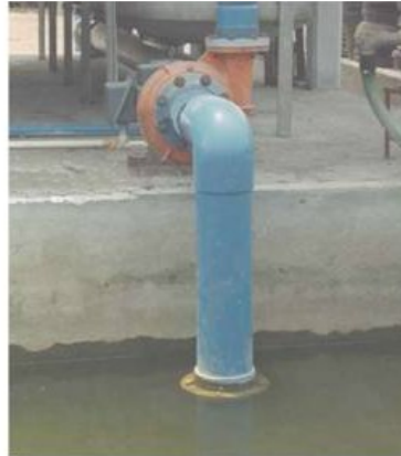
Fig. 53. Instalación típica de la tubería de succión
