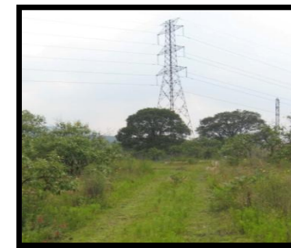
Imagen 4.i. Camino de terracería.
