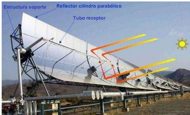
Figura 20: Sistema de concentración parabólico
