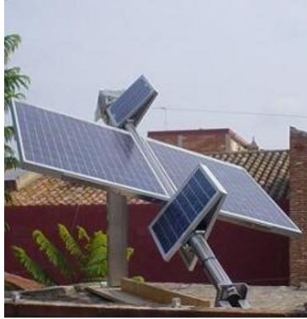
Figura 3: Sistema de seguimiento polar
