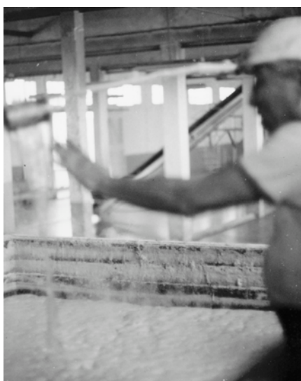
Figura 3.11. Durante la re nación, para ayudar en el proceso de eliminación de humedad, tierra, residuos vegetales u otras impurezas, se agrega nuevamente ácido sulfúrico.
