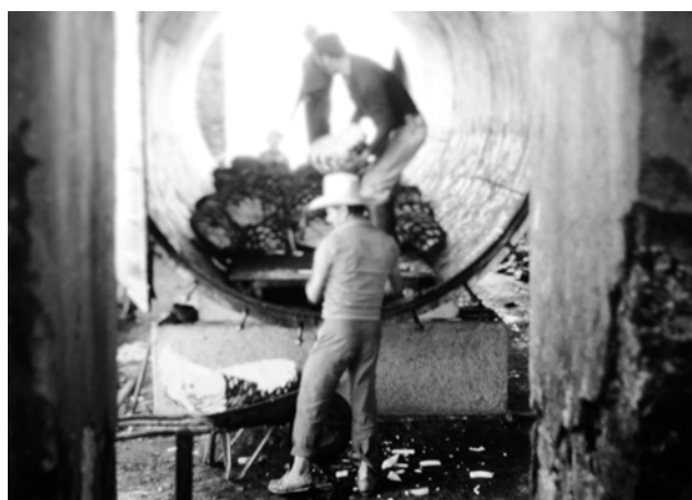
Figura 3.41. Operarios acomodando los trozos de agave en un autoclave. (Foto tomada desde el interior de un antiguo horno de mampostería, utilizado para el procesamiento tradicional del Tequila. (Arandas, Jal.).
