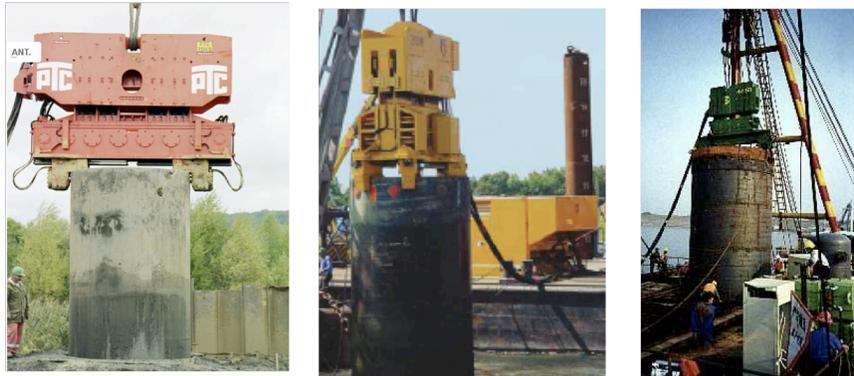
***Fig. 37 Izq.: Vibrohincador PTC. Medio:Vibrohincador LIEBHERR. Der.:Vibrohincador ICE***
