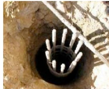
**Fig. 1. Acero de refuerzo en perforación**
