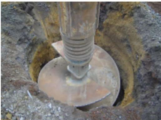
**Fig. 50. Perforación sin empleo de ademe metálico**
