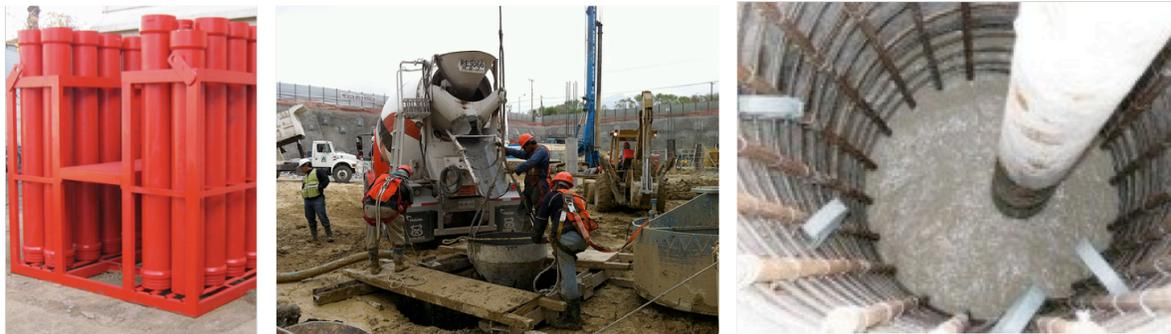
**Fig. 68. Izq. Tuebría Tremie SPIT&T. Medio y Der.:Vaciado de concreto en la perforación con tubería Tremie**
