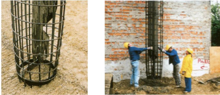
**Fig. 67. Perfil metálico auxiliar para la inmersión del armado en el concreto o mortero fresco. (Hudelmaier and Küfner 2009)**
