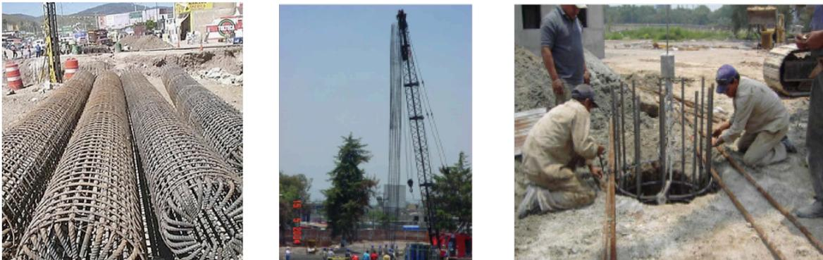
**Fig. 62. Izq. Habilitado y almacenamiento de acero. Medio: Izaje de acero de refuerzo. Der.: Colocación de acero de refuerzo en la perforación**
