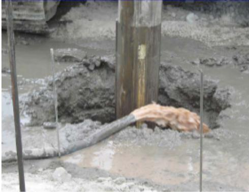
***Fig. 48. Estabilización con lodo bentonítico***
