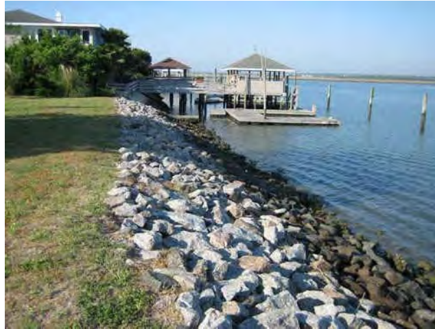
Figura 2. 12 Revestimiento de playa, utilizando material rocoso
