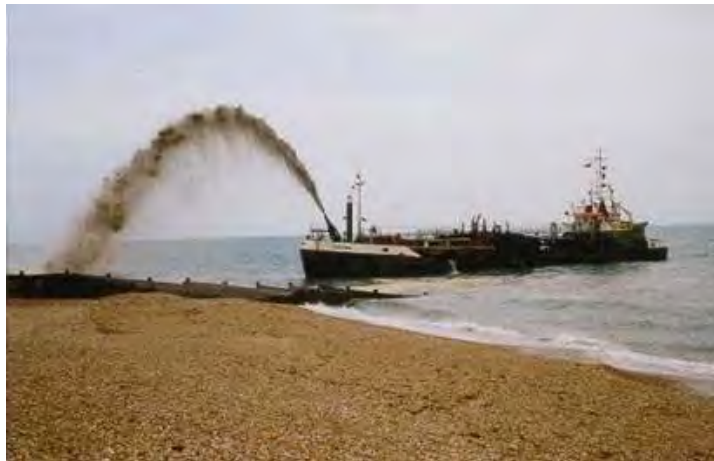
Figura 2. 3 Relleno de playa por bombeo de arena
