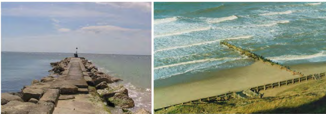
Figura 2. 6 Espigón de material rocoso (izq.), espigón de madera (der.)
