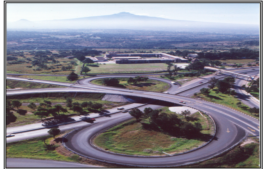
Carretera Federal Tlaxcala Apizaco.
