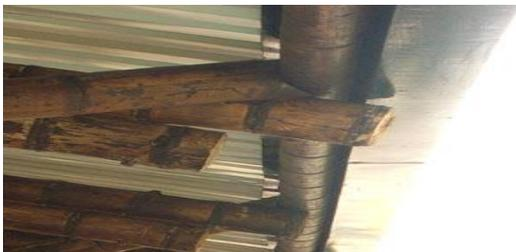
Para la producción se usa un escoplo (formón) o una broca. Con la broca y con la ayuda de un taladro eléctrico la boca de pescado puede ser elaborada rápido y limpio, siendo también la solución más costosa cuando solo se trabaja con herramienta manual.
