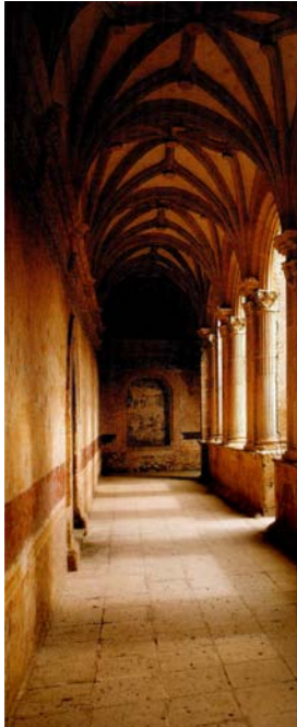
Fig. 1 Gradiente de textura en superficie longitudinal Galería del Claustro Bajo Ex convento de Santa Ma. Magdalena Cuitzeo, Michoacán
