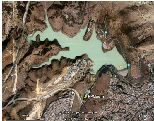
Figura 3.1 Vista satelital de la presa Madín (Google Earth, 2009)
