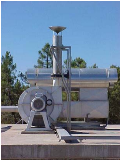
Figura 2. 20 Destructor de ozono térmico
