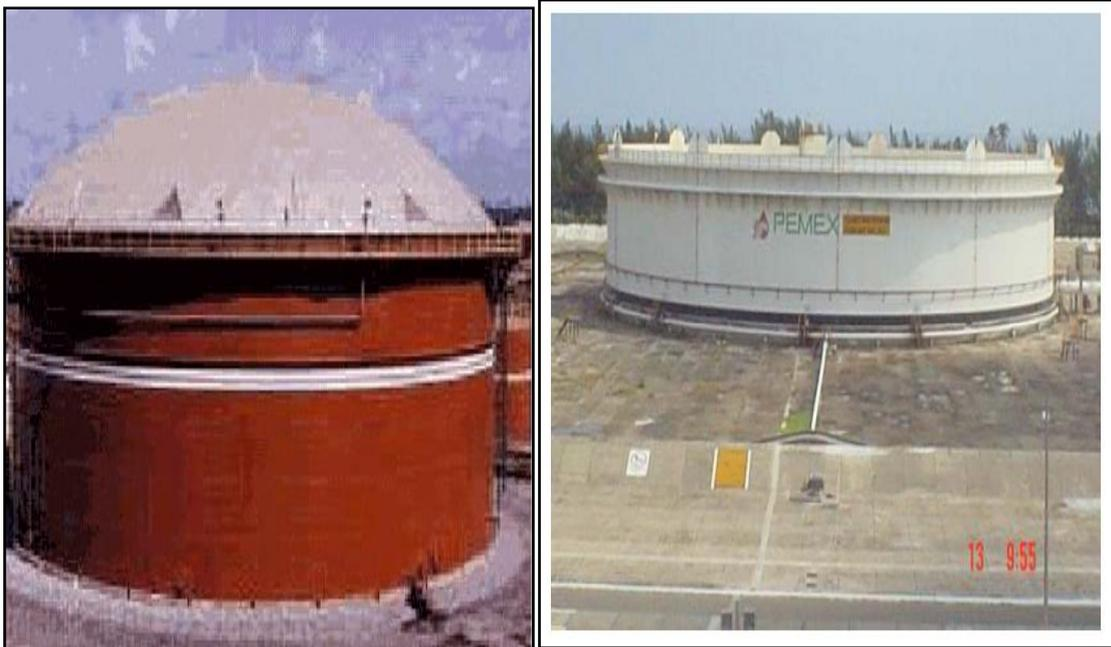
Fig.1.4 Tanques de almacenamiento de techo flotante. (Ref.32)
