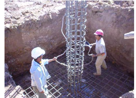
Fotografía 4.3 Colocación del armado
