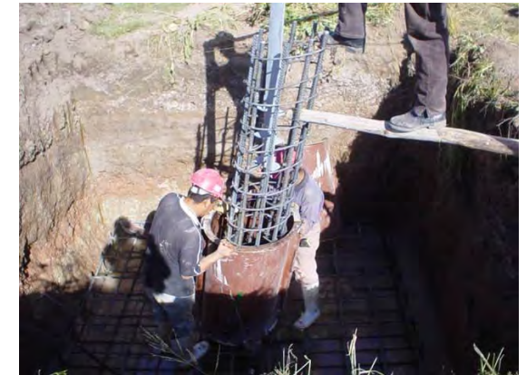
Fotografía 4.6 Cimbrado del dado
