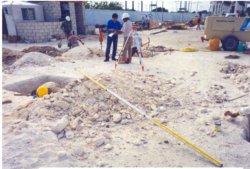
Fotografía 5.6 Trazo y excavación de las zapatas
