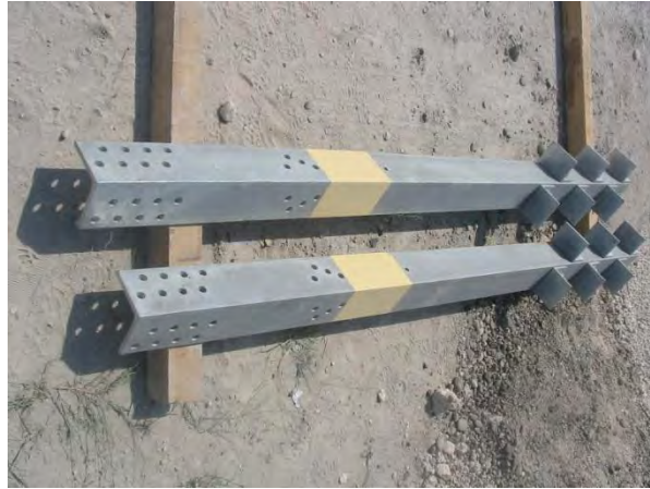
Fotografía 3.3 Armado de stubs
