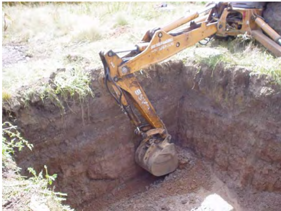
Fotografía 4.1 Excavación de la cepa
