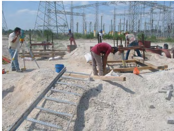
Fotografía 3.4 Nivelado de stub
