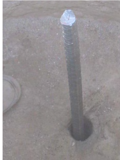
Fotografía 5.2 Colocación del ancla
