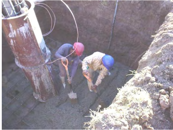
Fotografía 4.7 Colado de la zapata
