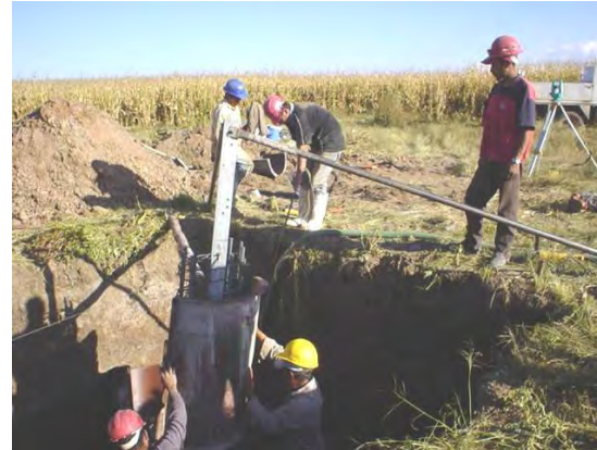
Fotografía 4.5 Cimbrado del dado
