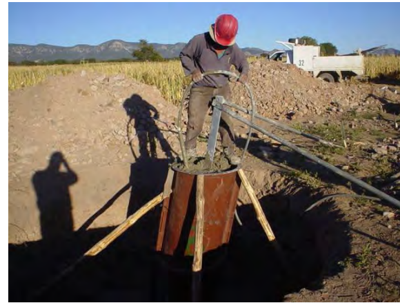
Fotografía 4.8 Colado del dado
