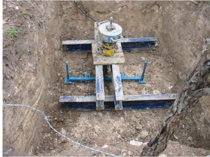
Fotografía 5.4 Colocación de viguetas para la extracción del ancla
