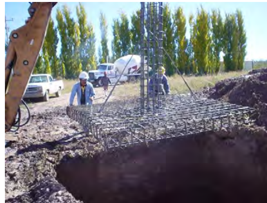
Fotografía 4.2 Acero de refuerzo de la cimentación
