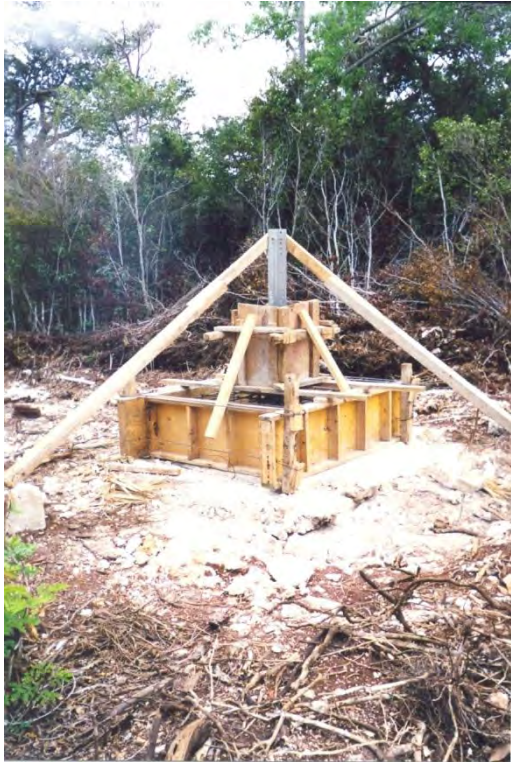
Fotografía 5.10 Cimentación para recibir el concreto
