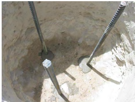
Fotografía 5.3 Colocación del ancla
