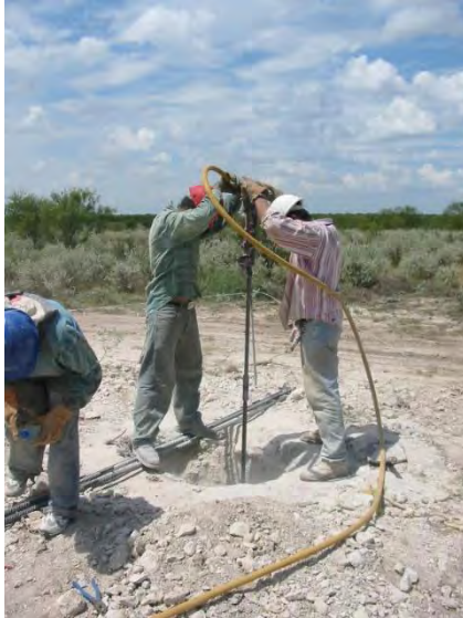
Fotografía 5.1 Perforación en roca
