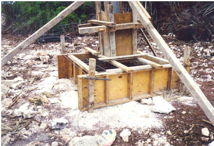
Fotografía 5.9 Preparada la cimentación para colar
