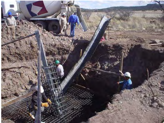
Fotografía 4.4 Preparación para el colado de la cimentación
