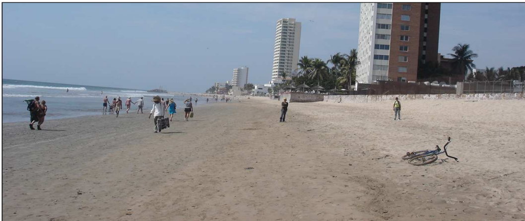
Figura II.19. Perfil morfológico de playa "g" (tomada en dirección SE-NW). Obsérvese la extensión de los muros de contención y cimientos de edificaciones, perturbando el desarrollo morfológico del litoral.
