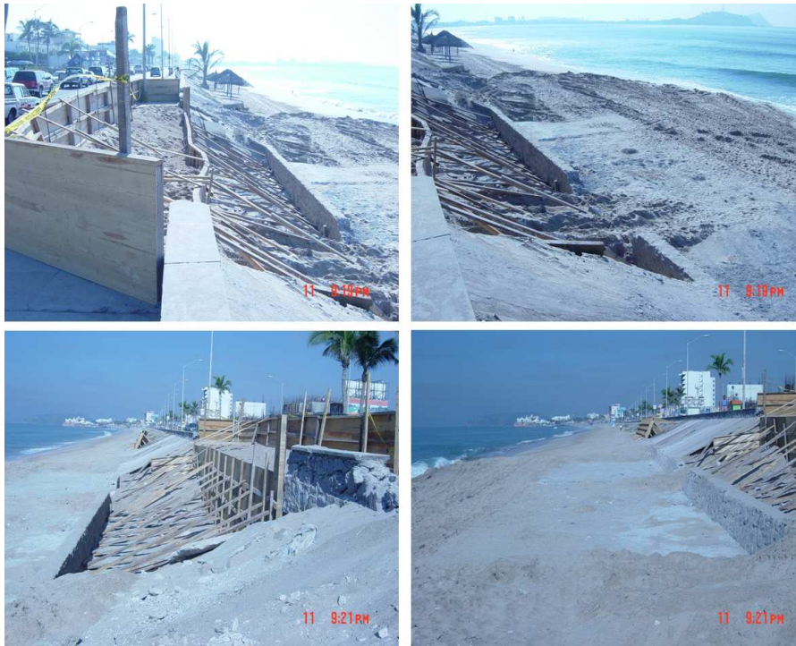
Figura III.24. Fotografías del sector Punta Camarón-Punta Tiburón, durante las obras realizadas como parte de la ampliación del malecón de Mazatlán (Noviembre de 2003).
