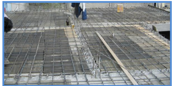
Fig. 24 Etapa de Construcción
