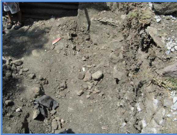
Fig.42 Foto de excavación muestra la proximidad de la parte rocosa del terreno.
