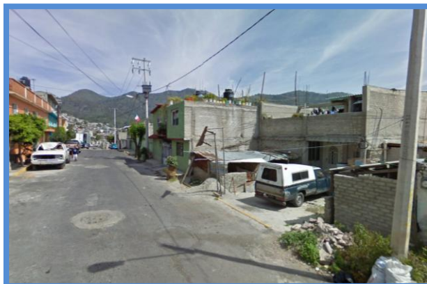
Av. Cerro del Mercado Vista Sur a Norte del Predio y de la Construcción existente.
