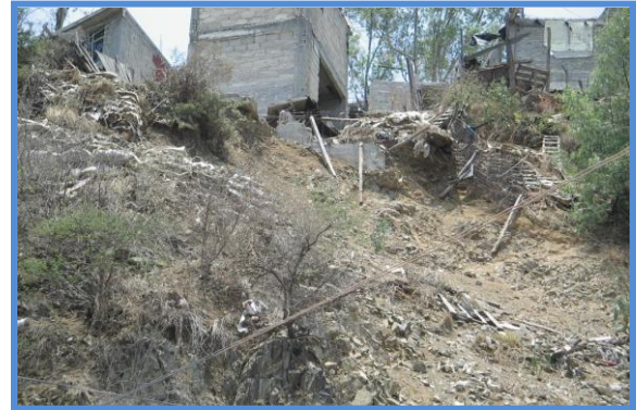
Fig. 55 Problemática de Deslizamientos de Tierra debido a la Erosión del Terreno.
