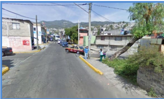
Fig. 50 Av. San Miguel y Nicandro Castillo, falta de mobiliario urbano, y señalizaciones.
