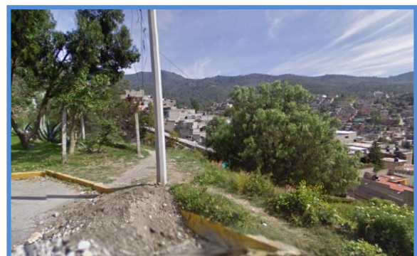
Fig. 60 Muestra Deterioro del Terreno, propuesto para Espacio Público.
