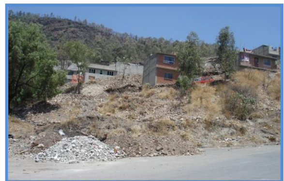
Fig. 57 Problemática de la Erosión del Terreno Av. Fujiyama.
