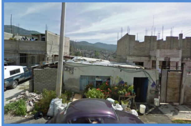
Vista Frontal del Predio y de la Construcción existente, muestra las condiciones de precariedad.
