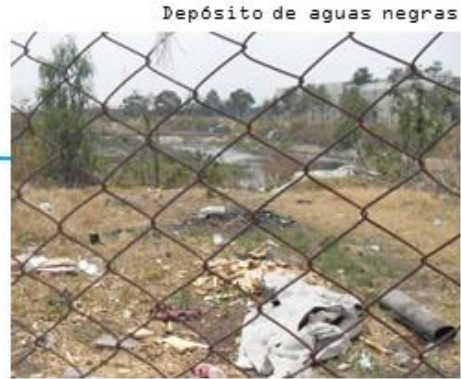
Depósito de aguas negras
