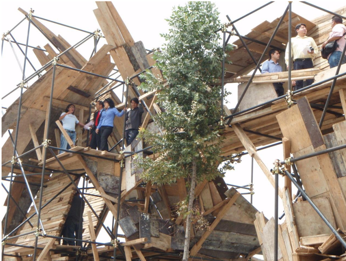
8.5. Vista frontal de la Intervención Reconstrucción del Muro
