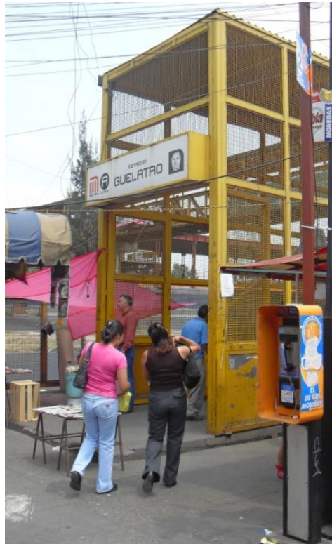
8.17. Acceso a la estación de Metro Guelatao frente a la FES Zaragoza
