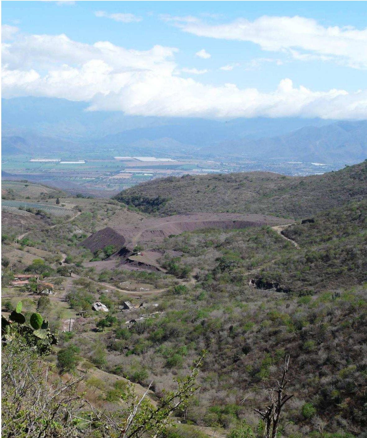
Depósito de material estéril producto de las antiguas operaciones del lugar, y ruinas de la antigua planta concentradora.
