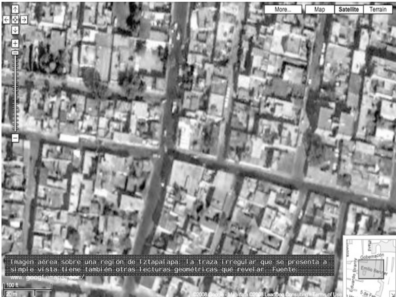
Figura 2.1: Vista aérea de las de la avenida Emilio Berliner, en la colonia España, Delegación Iztapalapa; México D.F.
