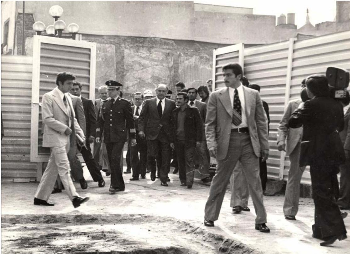
Arribo del presidente José López Portillo al sitio de la excavación (esquina de Guatemala y Argentina, en el Centro de la Ciudad de México), el 20 de febrero de 1978. Foto: Archivo de Raúl Arana.
