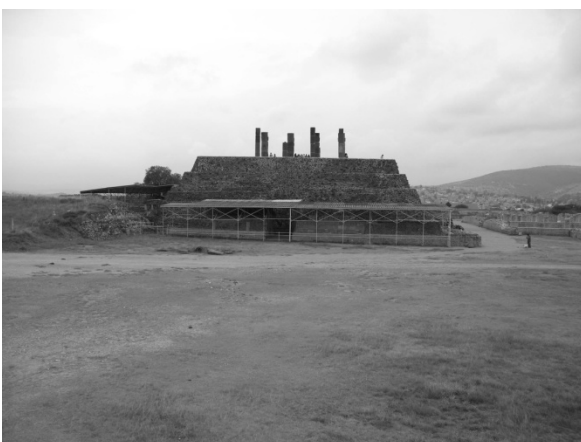
Figura 13. Vista general del Edificio B
