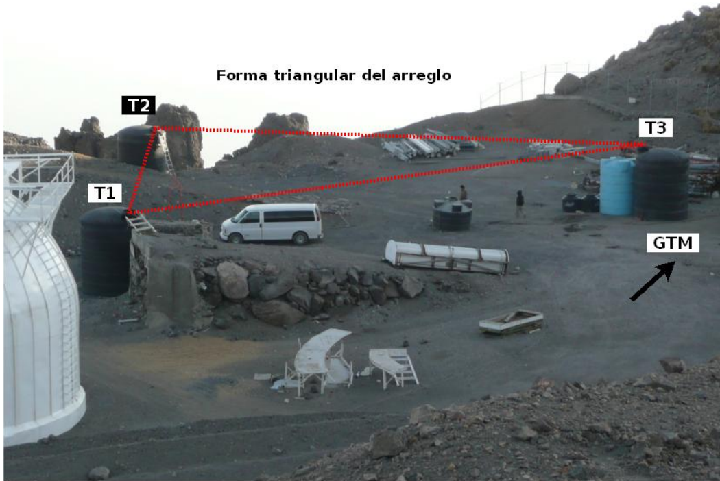
Figura 3.6: Arreglo de los tanques en la cima de Sierra Negra. Los tanques Rotoplas están denotados como T1 , T2 y T3 . El primer prototipo HAWC se localiza a un kilómetro del sitio oficial de HAWC.
