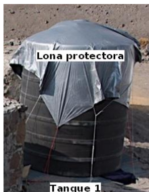
Figura 5.46: Montaje final del tanque 1, con su lona de protección.
