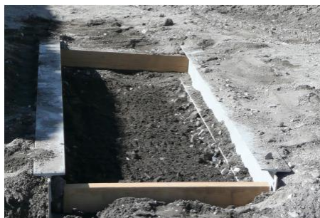
Figura 5.37: Zanja para la paleta de centelleo.
