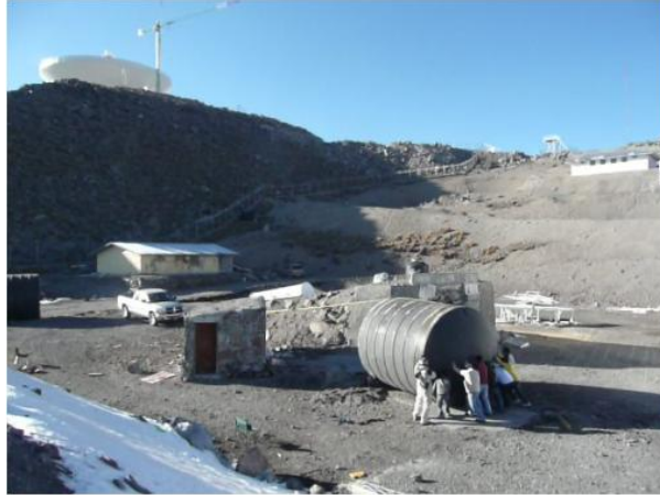
Figura 5.39: Montaje del tanque 1 (T1) en su respectivo cimiento.
