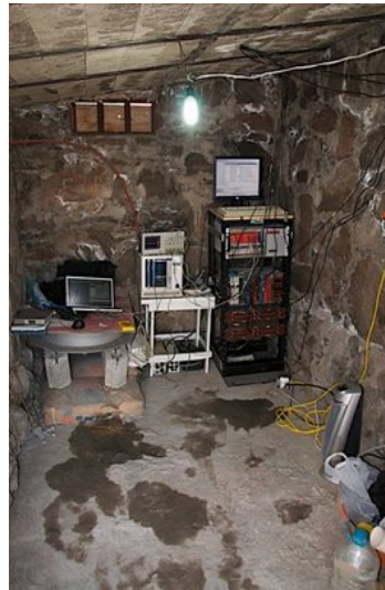
Figura 5.53: Interior de la caseta de control, donde se puede notar el montaje de los sistemas NIM, CAMAC y VME.
