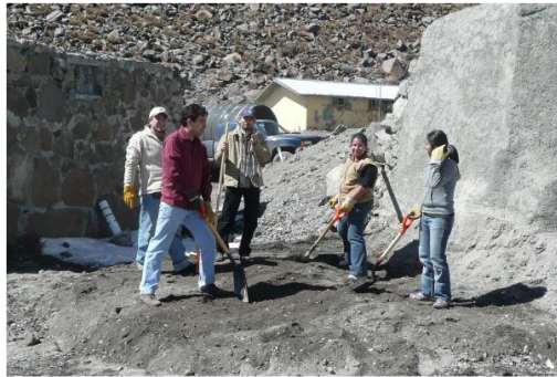
Figura 5.36: Construcción del cimiento para el tanque 1 (T1).
