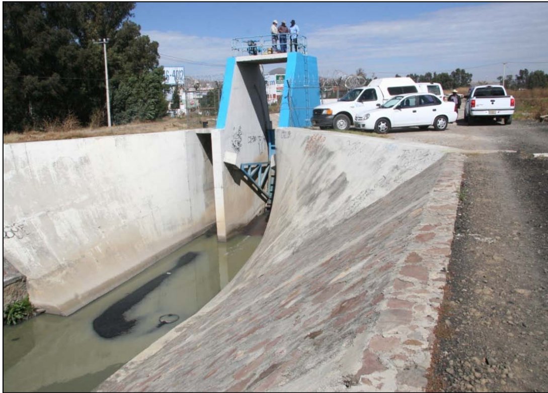
Figura 1.1.4.1b Vista aguas abajo de la derivadora San Francisco.
