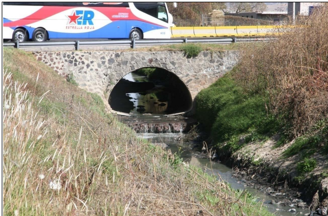
Figura 2.1.1. 2 Alcantarilla del cruce con la Autopista México-Puebla.
