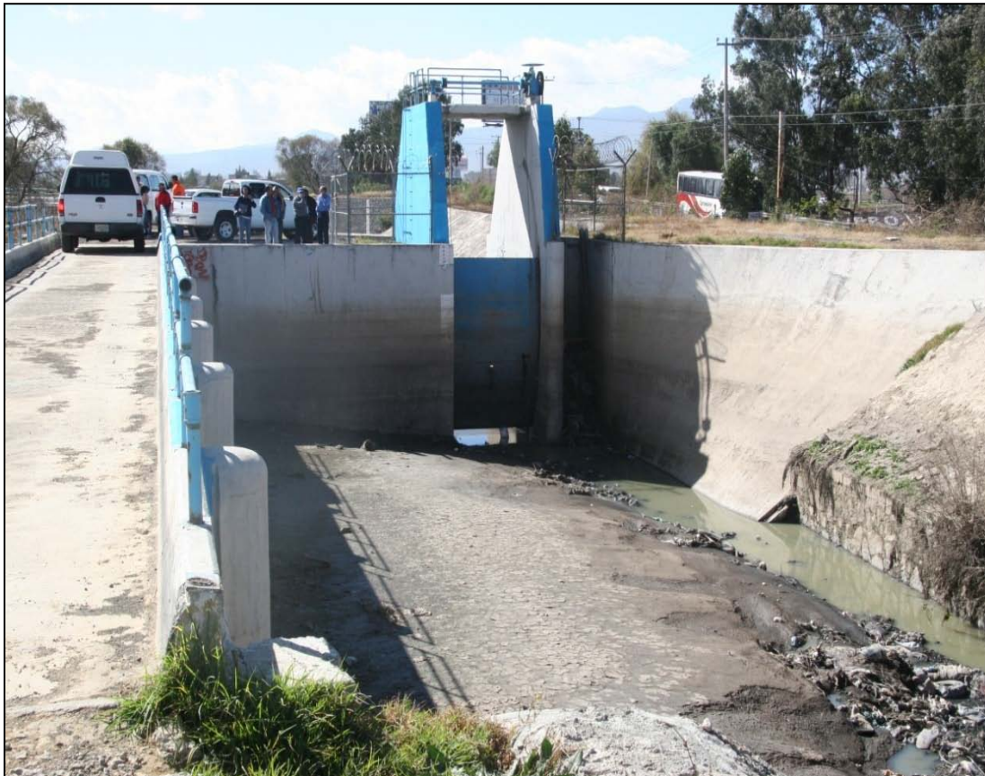
Figura 1.1.4.1a Vista aguas arriba de la derivadora San Francisco.
