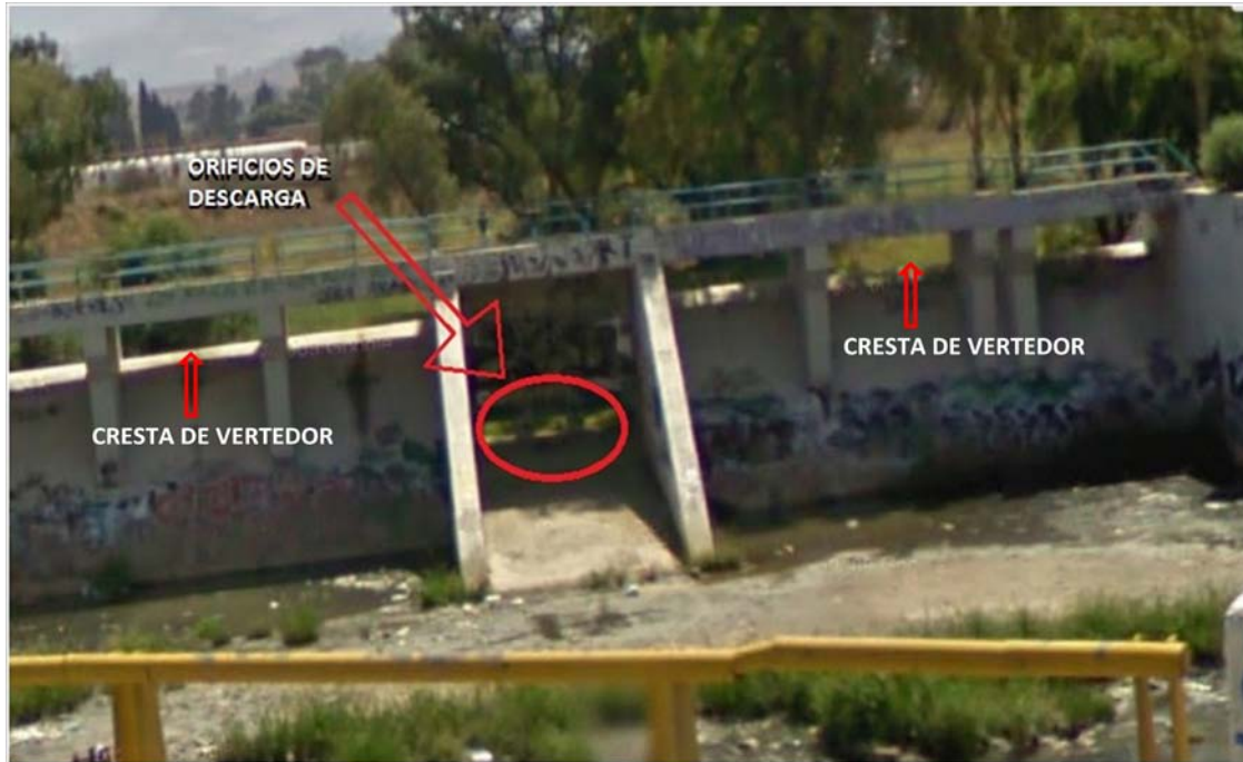
Figura 1.1.1. 1 Estructura de descarga de la laguna la Gasera.
