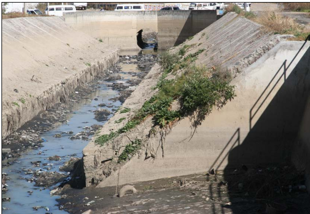
Figura 2.1.1. 3 Alcantarilla del cruce con la carretera a San Marcos Huixtoco.
