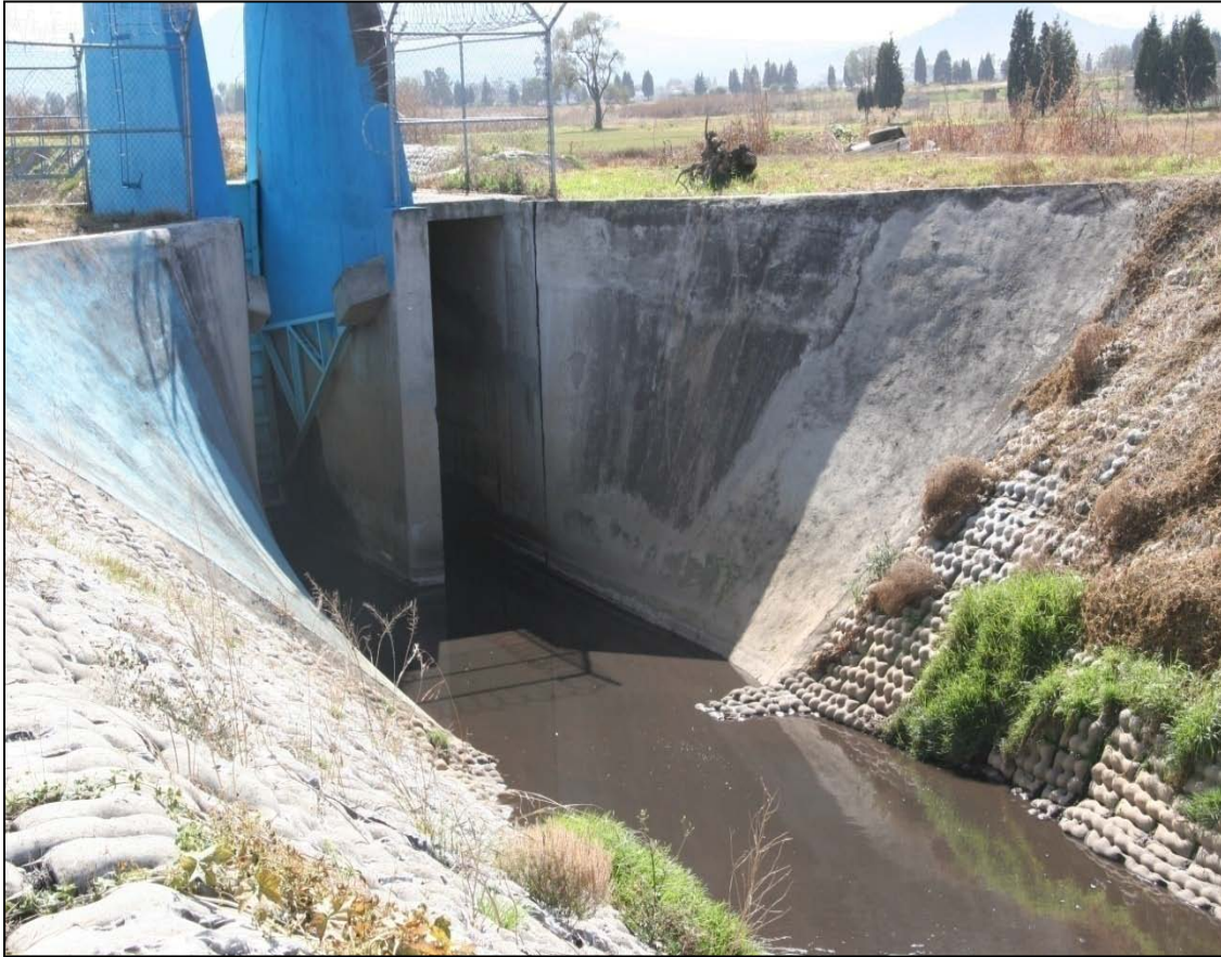
Figura 1.1.3.1b Vista aguas abajo de la derivadora San Rafael.
