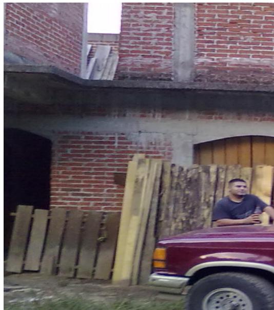
Fotografía 3.3. Estructura ubicada al poniente de San Lorenzo. (Fuente propia)
