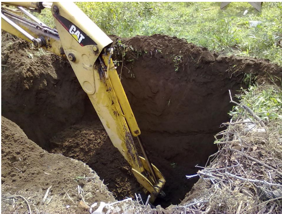
Fotografía 5.1.- Excavación del sondeo.
